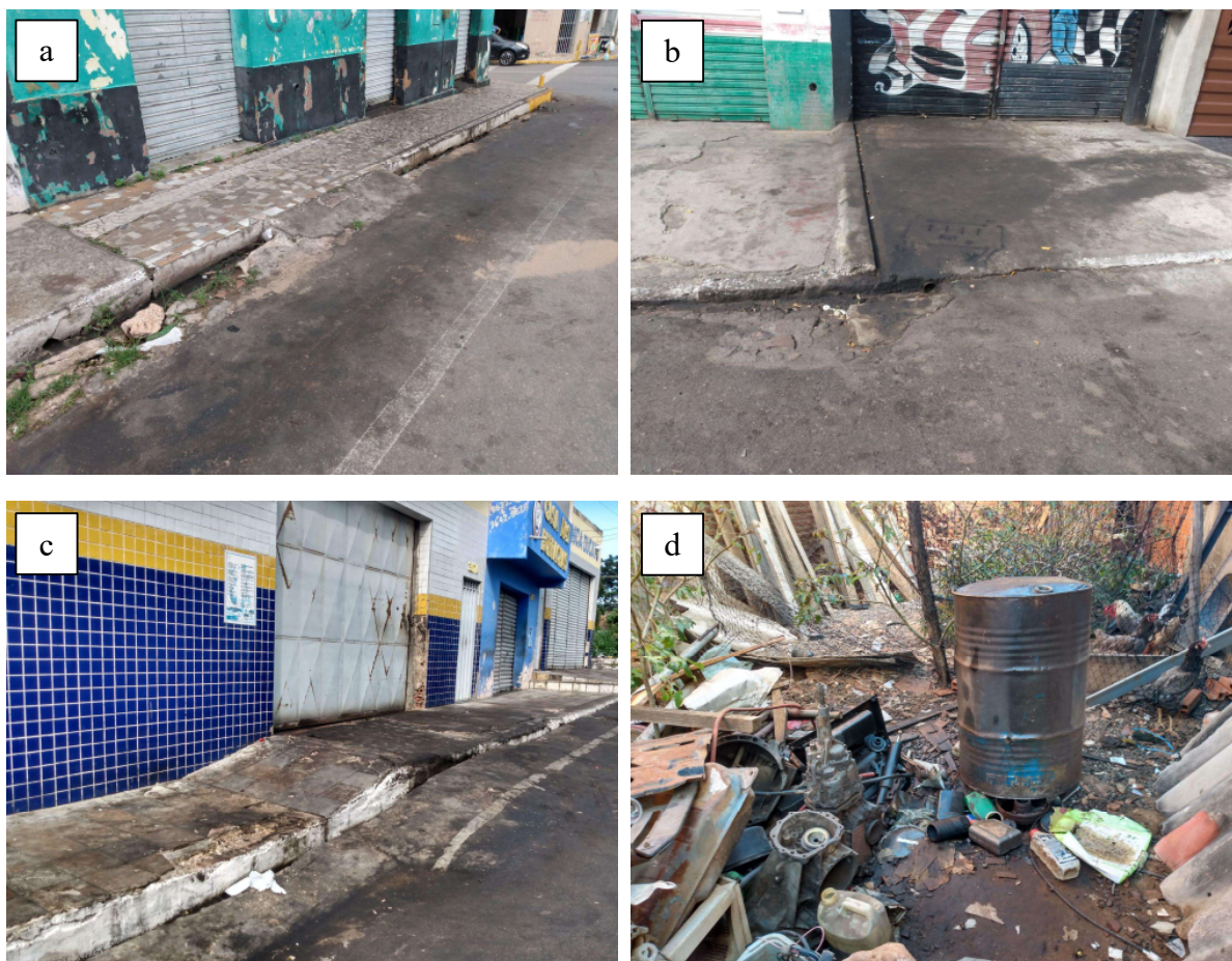
Figura 24 - Situações de derramamento de óleo em Juazeiro do Norte - CE, 2021
