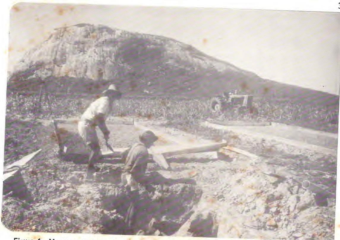
Figura 1. Montagem das parcelas observando-se detalhes da sua demarcação e assentamento da calha coletora.
