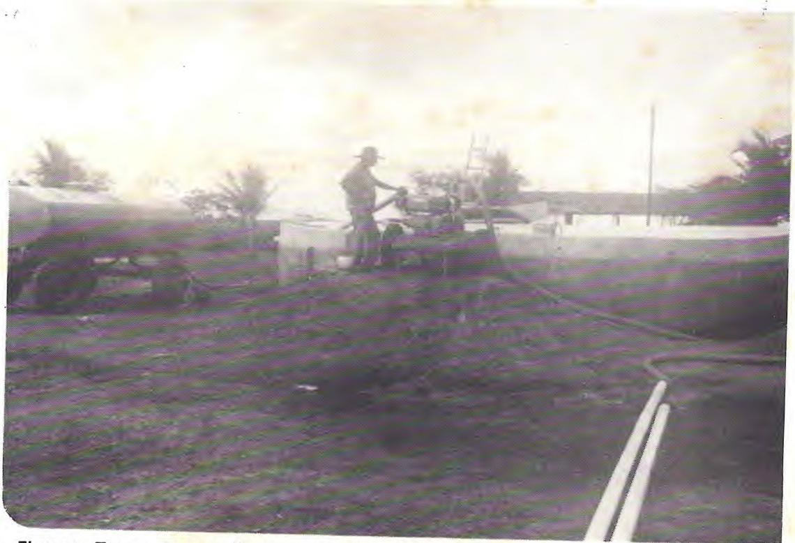
Figura 4. Tanque de captação com o conjunto motobomba para o abastecimento de água para o Simulador.
