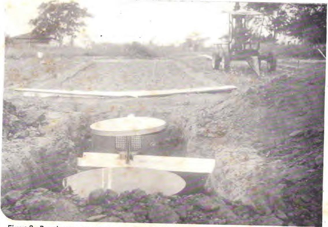
Figura 3. Parcela com sua estrutura montada: lâminas de demarcação, calha coletora, tanque coletor de sedimentos e tanque coletor de deflúvio.
