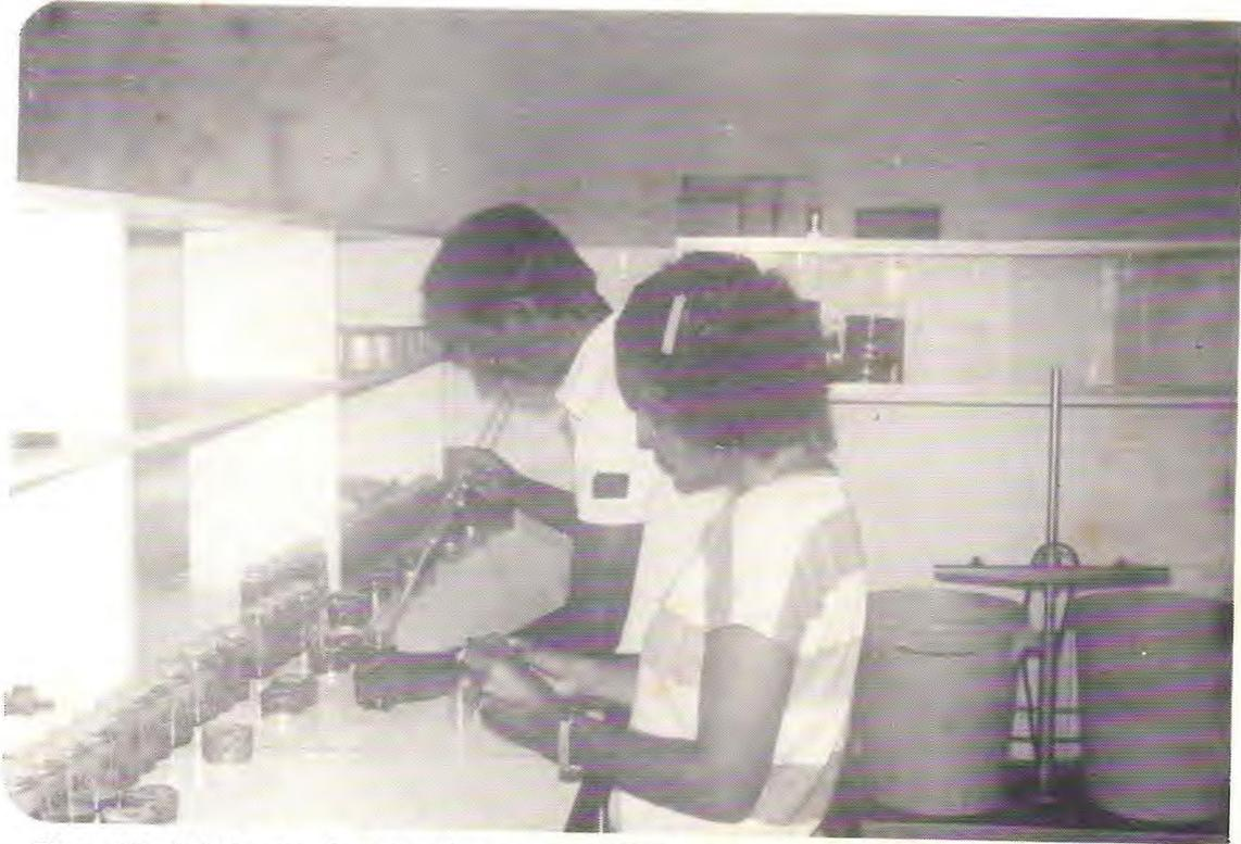
Figura 10. Detalhe da coleta das alíquotas da suspensão para determinação da terra em suspensão.
