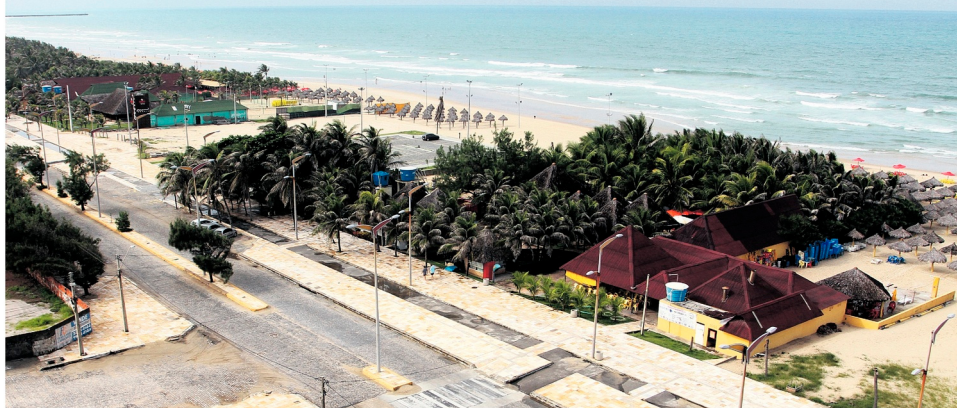
Ação Civil Pública de 2005 pede demolição de todas as barracas da Praia do Futuro. Estimativa é que apenas dez empreendimentos estejam em total conformidade com as determinações
