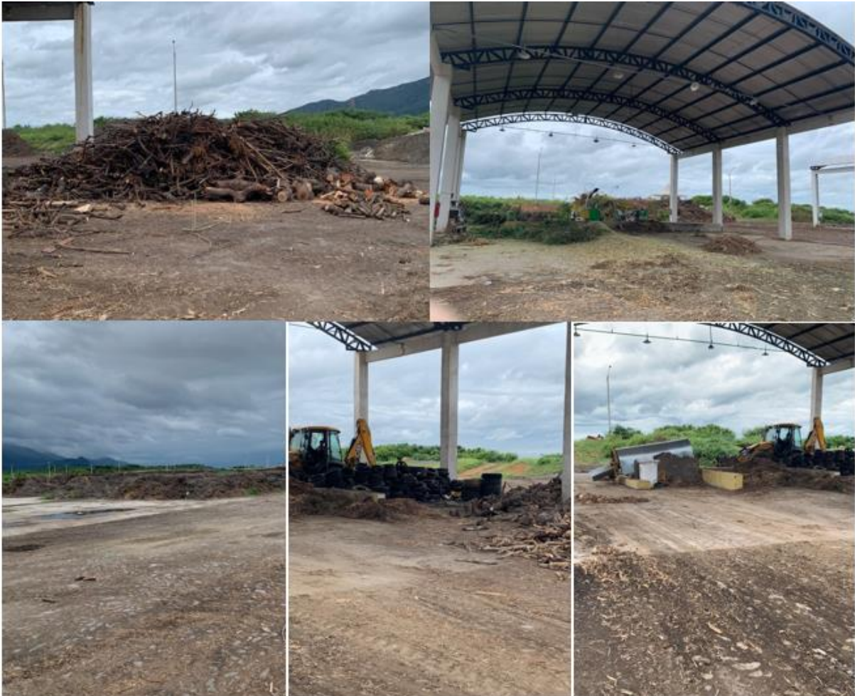
Figura 11- Setor de compostagem localizado na central de tratamento de resíduos de Sobral
