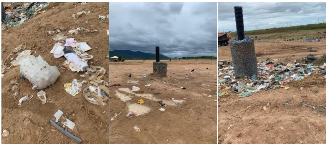
Figura 8- Sistema de drenagem e presença de rejeitos na trincheira da central de tratamento de resíduos de Sobral
