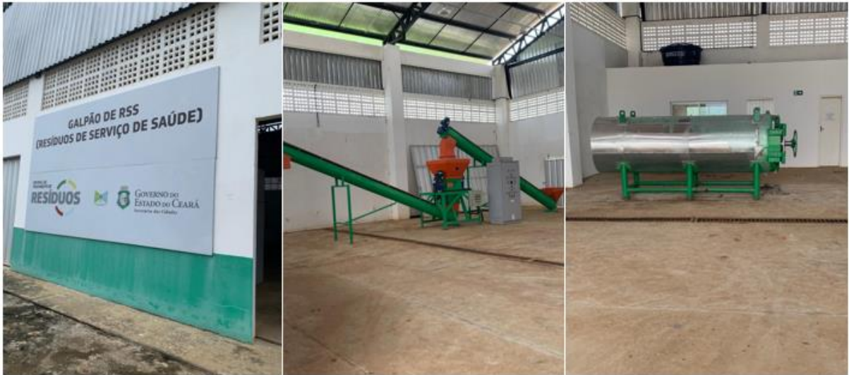
Figura 10- Galpão de resíduos sólidos de saúde localizado na central de tratamento de resíduos de Sobral
