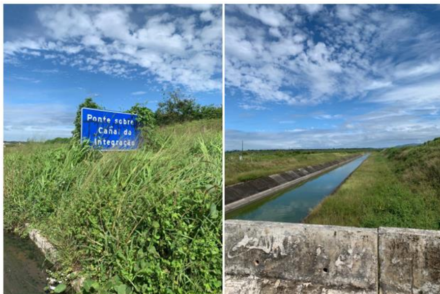
Figura 20- Canal de integração localizado próximo ao lixão de Pacajus
