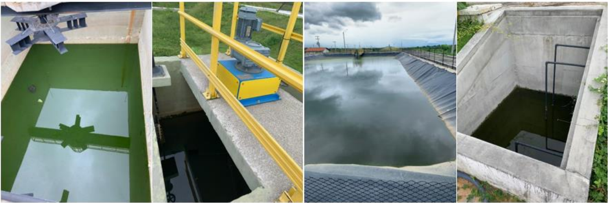
Figura 9- Estação de tratamento de efluentes da central de resíduos de Sobral
