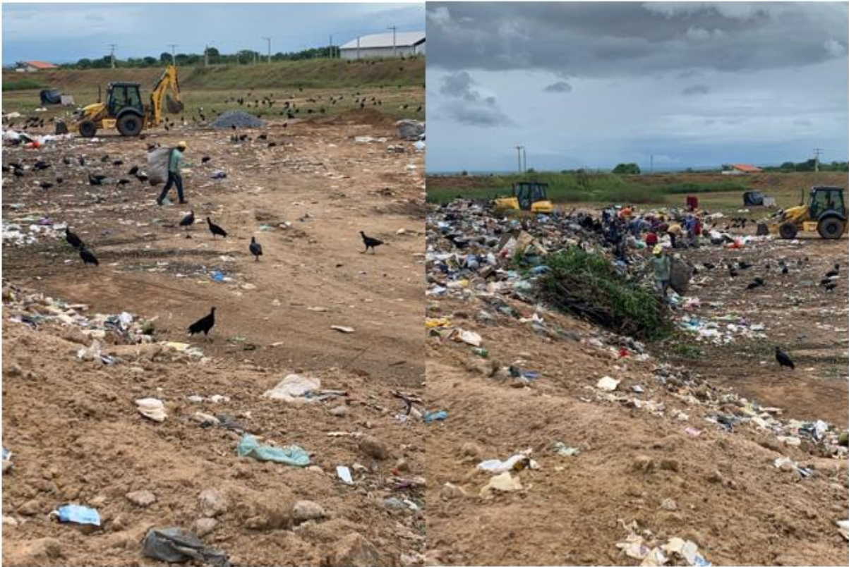
Figura 7- Trincheira da central de tratamento de resíduos de Sobral
