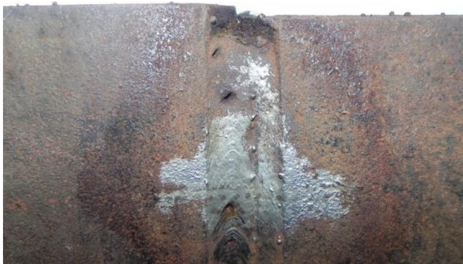
Figura 55 – Foto da junta CCR2 após o quinto passe de soldagem.
