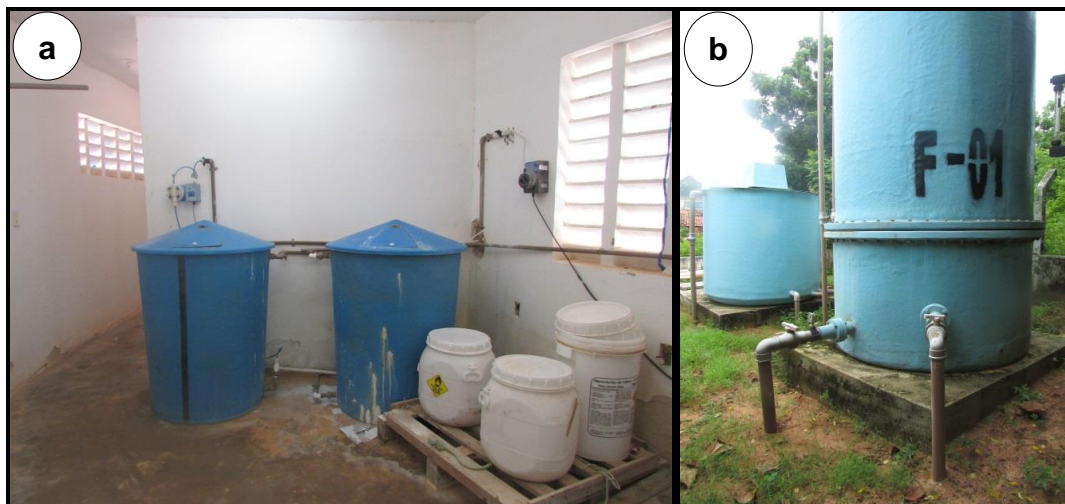
Figura 13 – Tratamento de água da Vila de Jericoacoara. (a) tratamento por hipoclorito de cálcio – ativo, (b) tratamento bacteriológico – desativado
