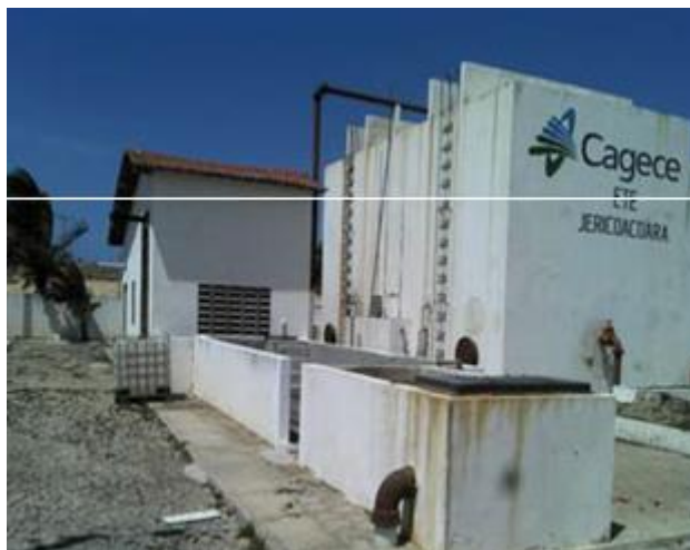
Figura 15 – Estação de Tratamento de Esgoto (ETE)
