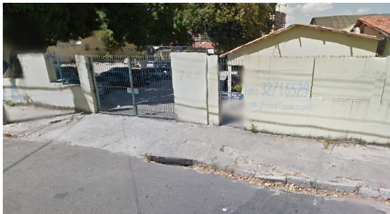
Figura 2 – Pavimentação da calçada
