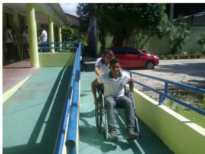
Figura 5 e 6 – Rampa do bloco principal
