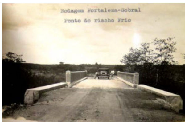
Figura 24 - Ponte sobre o riacho Frio (IFOCS,1929)
