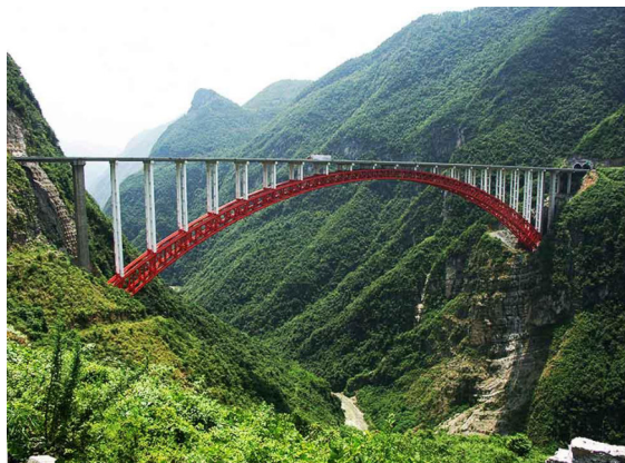
Figura 7 - Ponte sobre o Rio Zhijinghe, na China.
