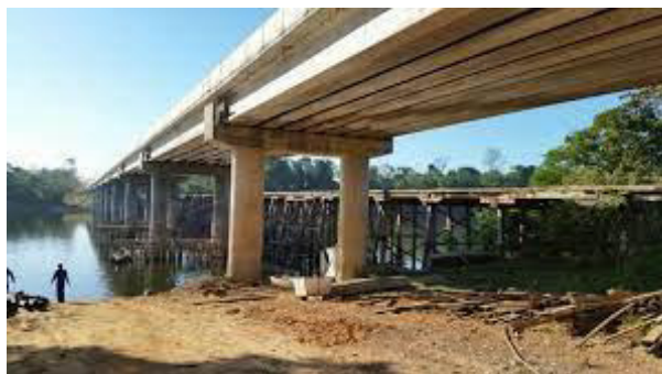
Figura 5 - Ponte sobre o rio Aripuanã, Mato Grosso-Brasil.
