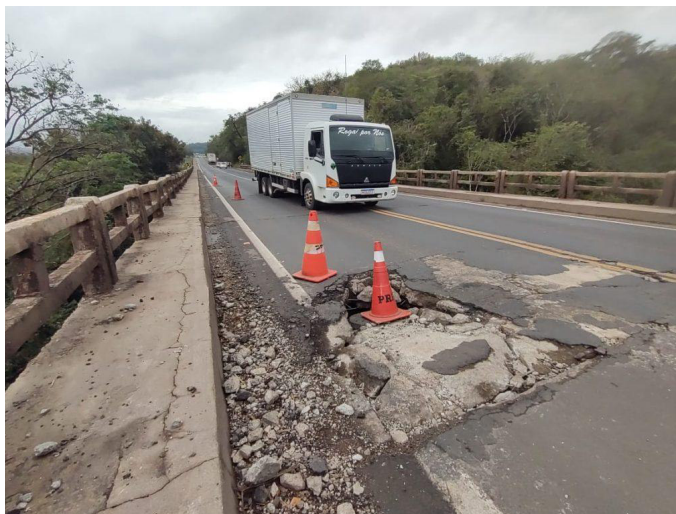
Figura 18 - Ponte Ubá BR-153
