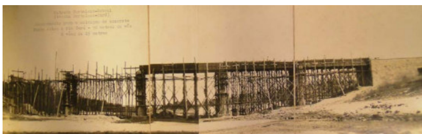
Figura 26 - Construção da Ponte sobre o rio Curú
