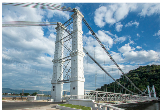
Figura 8 - Exemplo de Ponte Pênsil, Ponte de São Vicente 1914 - São Paulo.
