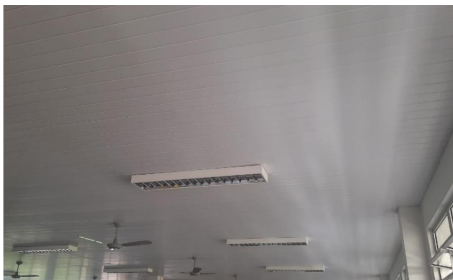
Figura 22 - Forro de PVC do teto do RU
