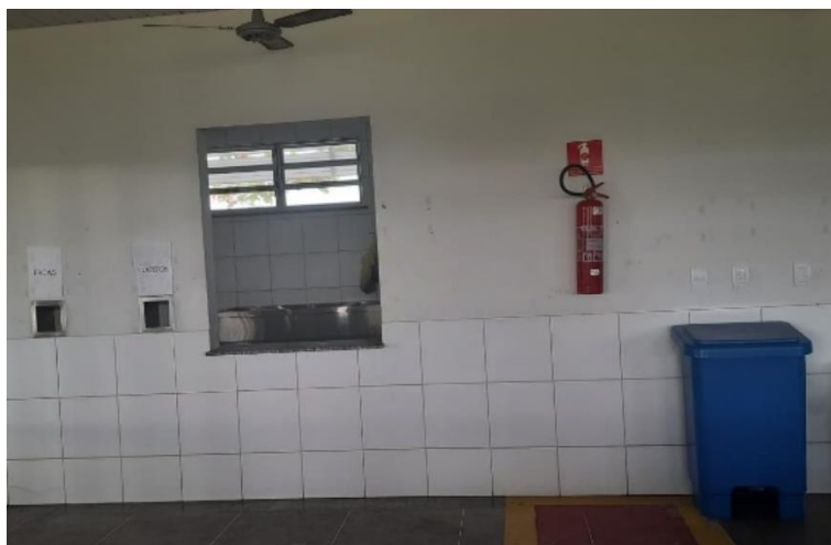
Figura 24 - Aberturas da sala de lavar louças
