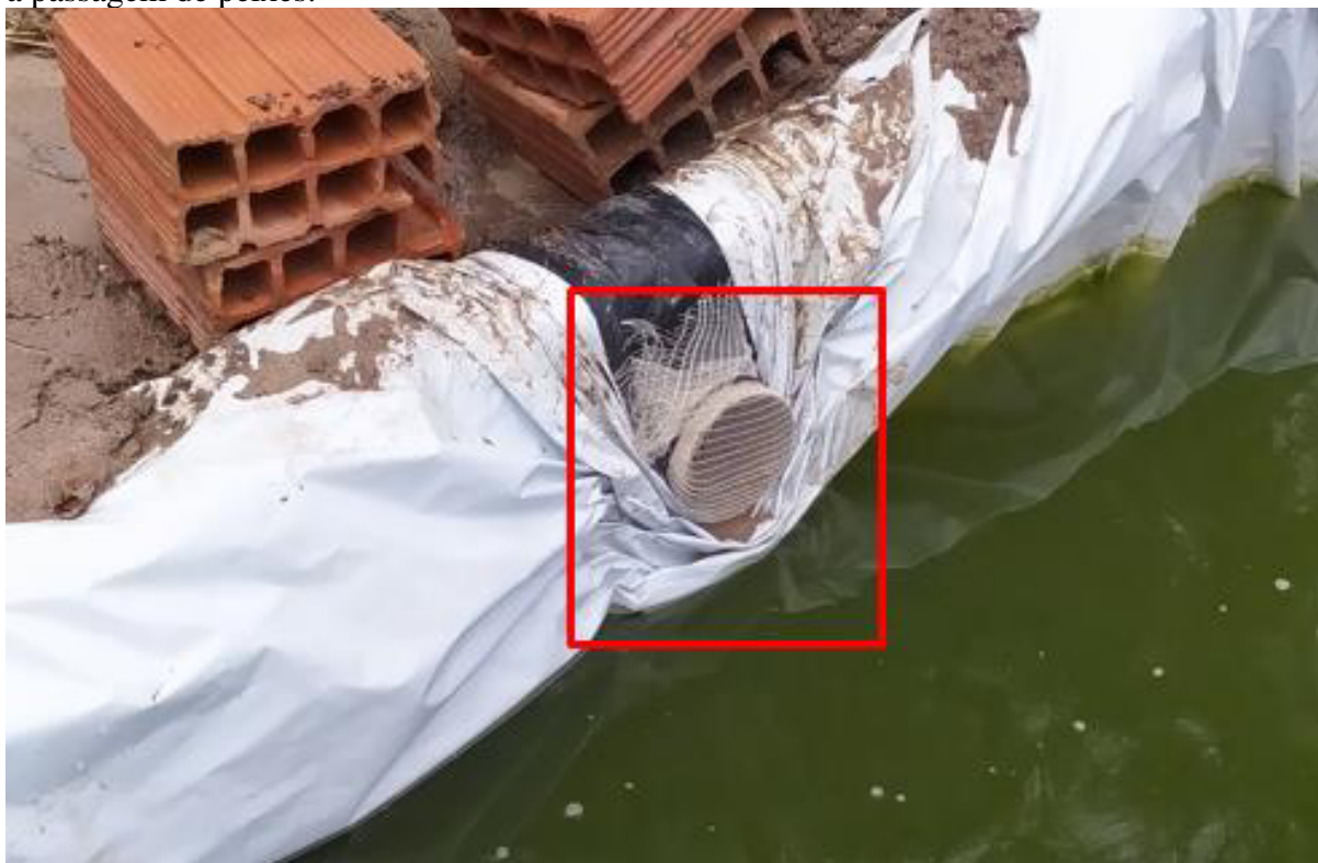
Figura 04. Dreno do tanque de peixes a 30 centímetros da borda tampado com tela para impedir a passagem de peixes.
