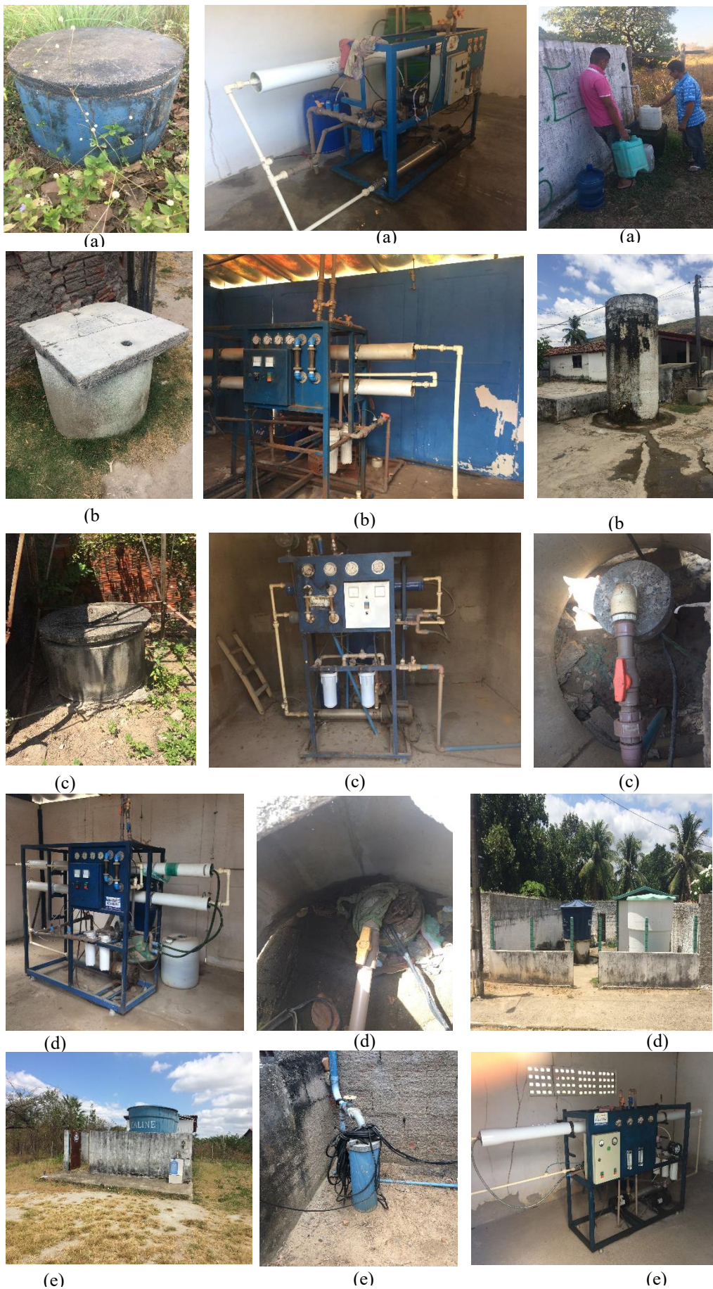
Figura 9 – Sistemas de Abastecimento das localidades estudadas com Poço profundo e Dessalinizador (a) Caraussanga (P1); (b) Porteira (P2); (c) Lameirão (P3); (d) Boqueirãozinho (P4) e (e)Angico (P5)
