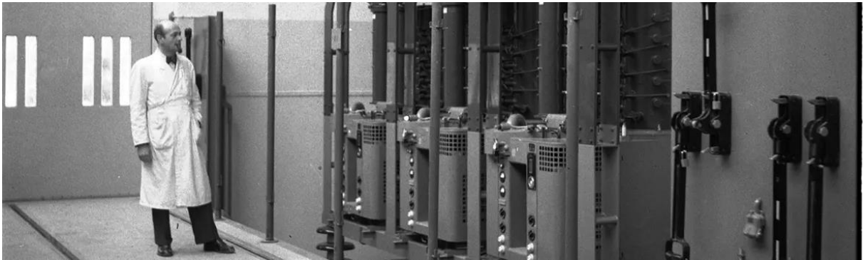
Figura 6. Uno Lamm olha para as válvulas retificadoras na estação de Gotland I na Suécia com tensão de 100kV e 20 MW de potência.
