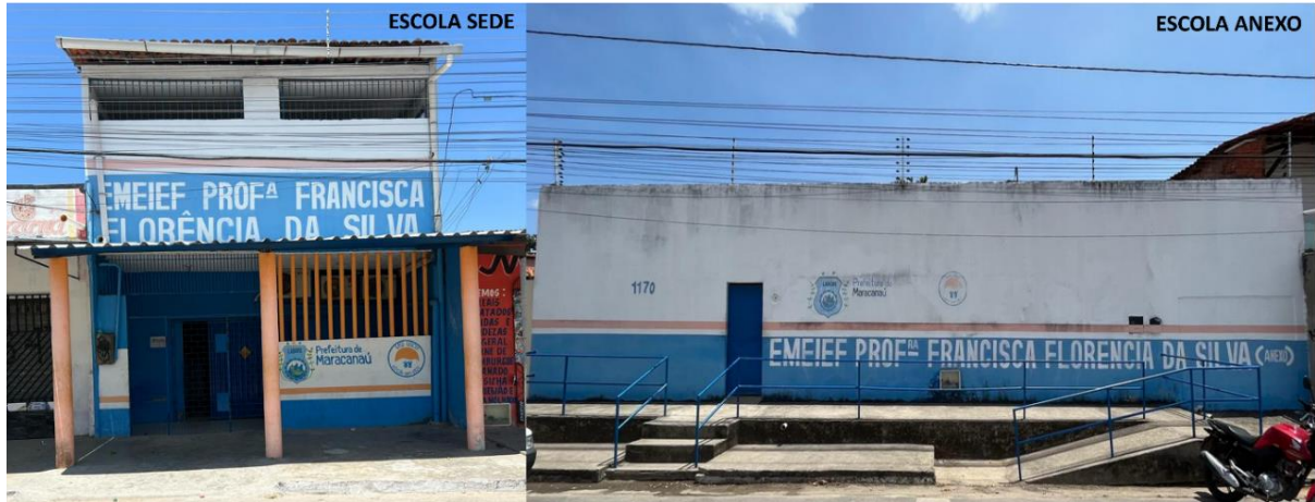
Foto 1 – Fachada da Escola Sede e Anexo
