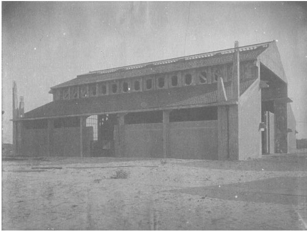
Figura 2.33 – Oficina de ferraria e fundição, foto de 1930. Fonte: Inventário Sumário do Patrimônio da RFFSA no Ceará, IPHAN (2008).
