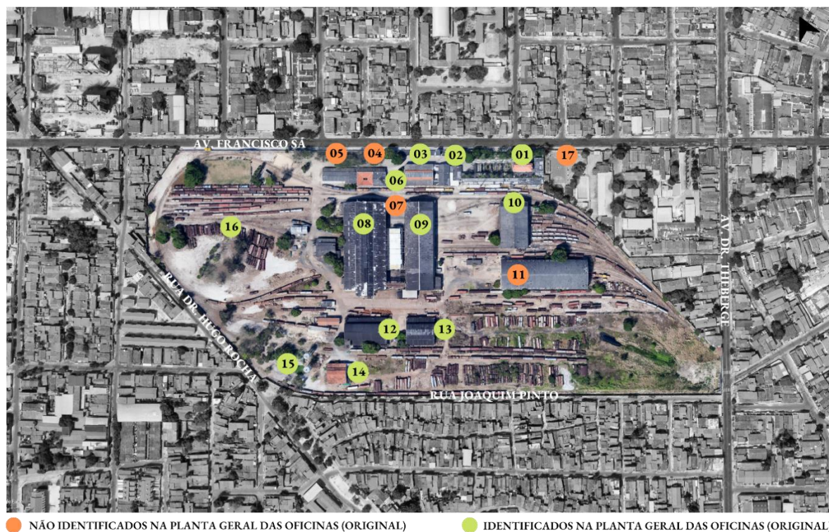
Figura 2.15 – Imagem aérea do conjunto industrial das Oficinas do Urubu com identificação dos usos: 01 - edifício administrativo; 02 – acesso, guarita e estacionamento; 03 - almoxarifado; 04 - serviços médicos e odontológicos; 05 - refeitório e lazer; 06 – acesso às oficinas; 07 – gerência; 08 - oficina de montagem e manutenção de locomotivas; 09 - oficina de reparação de carros e vagões; 10 - oficina de manutenção de vagões tanque; 11 - oficina de manutenção de equipamentos de via permanente; 12 e 13 - oficinas de ferraria e fundição; 14 - casa de força; 15 - caixas d'água; 16 – pátio; 17 - grêmio dos ferroviários. Fonte: Imagem do Google Earth Pro com alterações da autora (2021).
