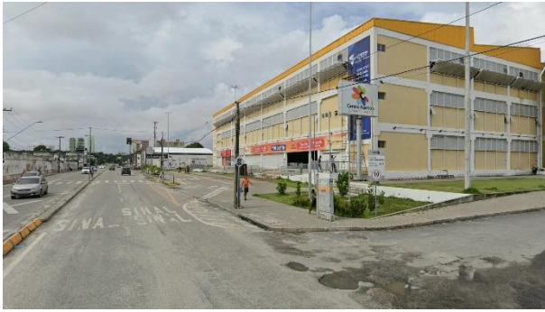
Figura 2.45 – Centro Fashion, construído no lugar da antiga Fábrica São José, imagem de 2019. Fonte: Google Street View (online) .
