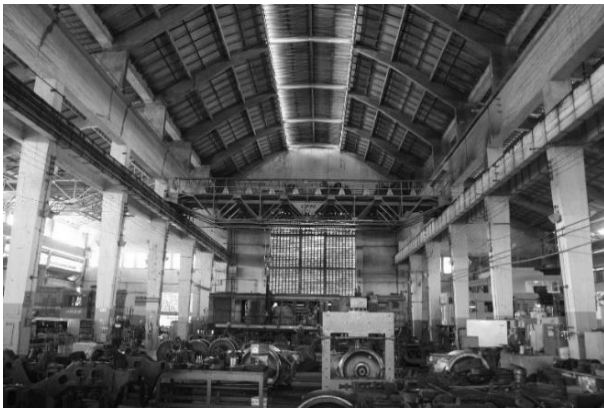
Figura 2.28 – Área interna da oficina de montagem e reparação de locomotivas, nota-se a substituição das telhas do vão central, que antes eram translúcidas, foto de 2017. Fonte: Acervo da autora.
