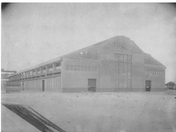
Figura 2.20 – Oficina de montagem e reparação de locomotivas, foto de 1930. Fonte: Inventário Sumário do Patrimônio da RFFSA no Ceará, do IPHAN (2008).
