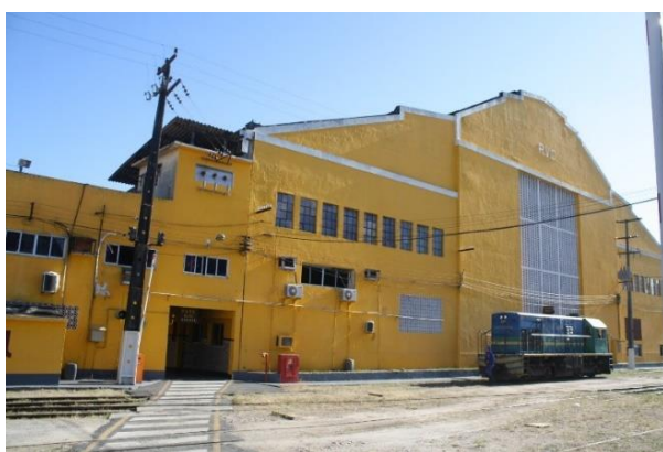
Figura 2.26 – Oficina de montagem e reparação de locomotivas, foto de 2017. Fonte: Acervo da autora.
