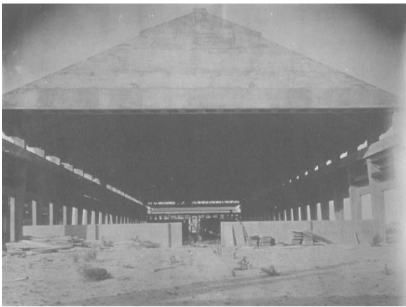
Figura 2.22 – Oficina de reparação de carros e vagões vão executado através de viga vierendeel, foto de 1930. Fonte: Acervo da RFFSA
