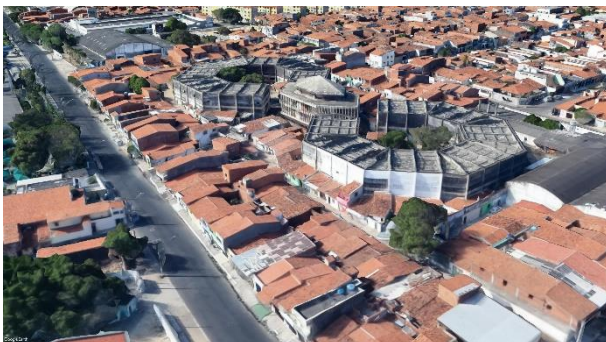
Figura 2.48 – Fábrica Vilejack, atualmente ocupada por habitações irregulares, imagem de 2019. Fonte: Google Street View (online).
