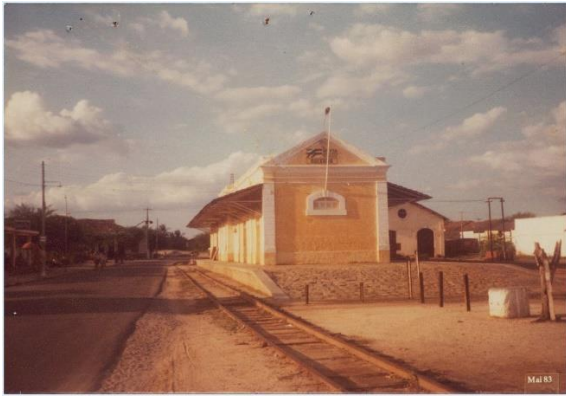
Figura 2.2 – Estação Ferroviária de Quixadá, em 1983. Fonte: Estações Ferroviárias (online).
