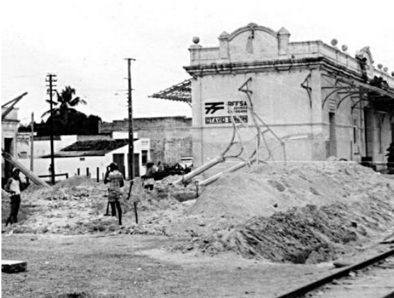
Figura 2.4 – Demolição da Estação Otávio Bonfim em 1979. Fonte: Estações Ferroviárias (online).
