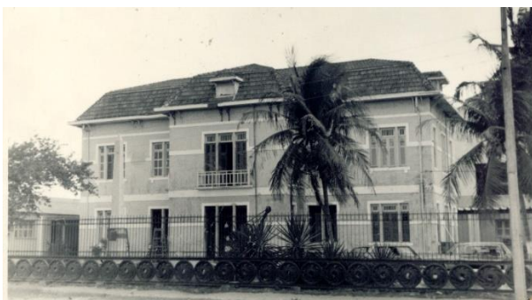
Figura 3.2 – Prédio administrativo das oficinas, década de 1930. Fonte: Acervo RFFSA.
