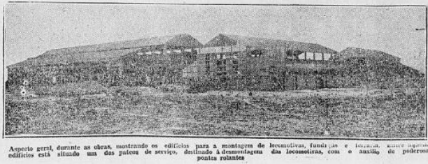
A gravura acima representa uma habilitada estrutura em concreto armado, abrangendo um vasto patio de quasi 33 metros de largura, e com a planta geral, tal que as materias primas e os vehiculos em reparação percorram o menor caminho possível.
