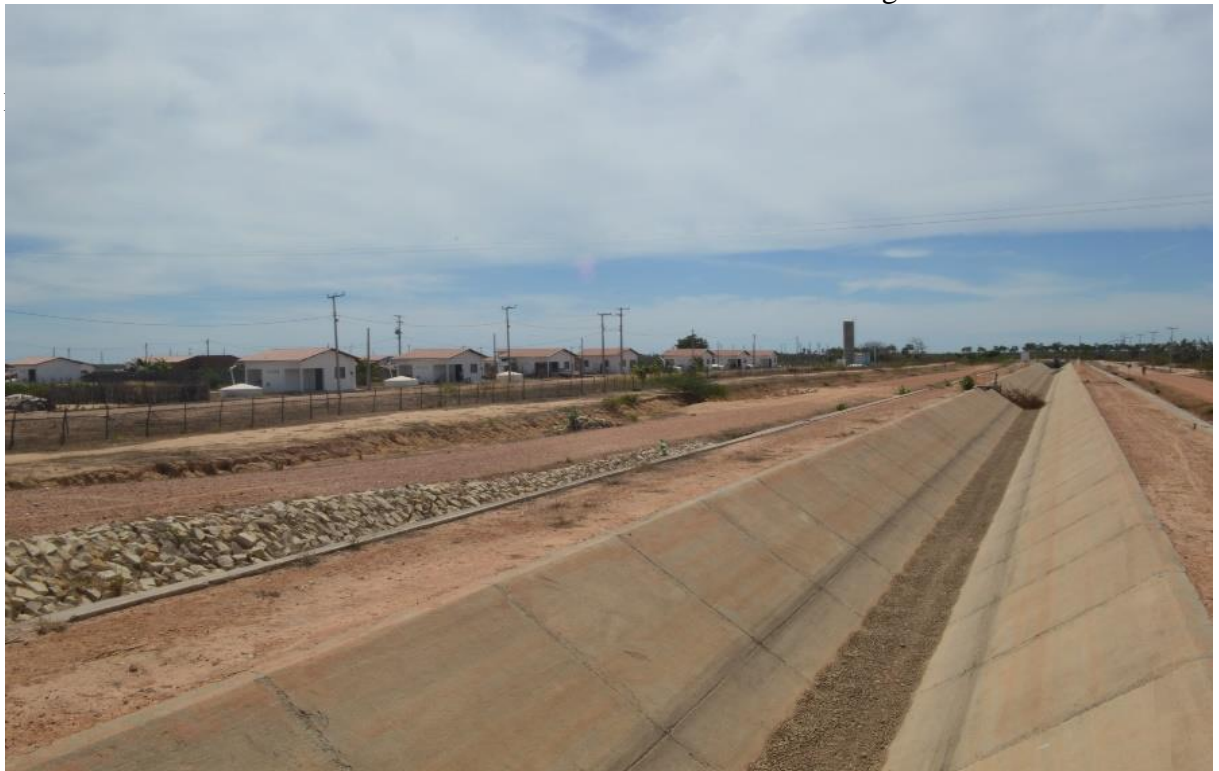
Foto 05 – Trecho do Perímetro Irrigado Tabuleiro de Russas (2ª Etapa) ainda sem água e ao fundo o reassentamento com 19 casas da comunidade Lagoa dos Cavalos
