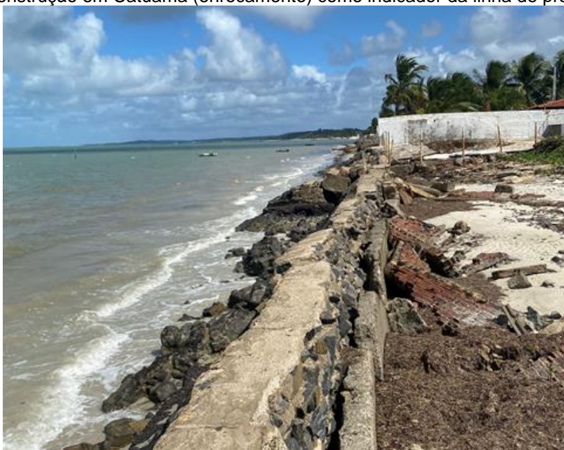
Figura 53 - Construção em Catuama (enrocamento) como indicador da linha de preamar máxima.
