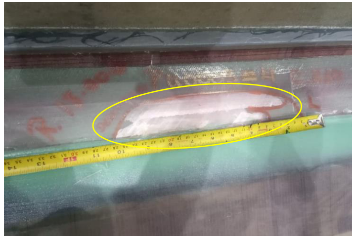
Figura 25 – Exemplo de trinca no laminado.
