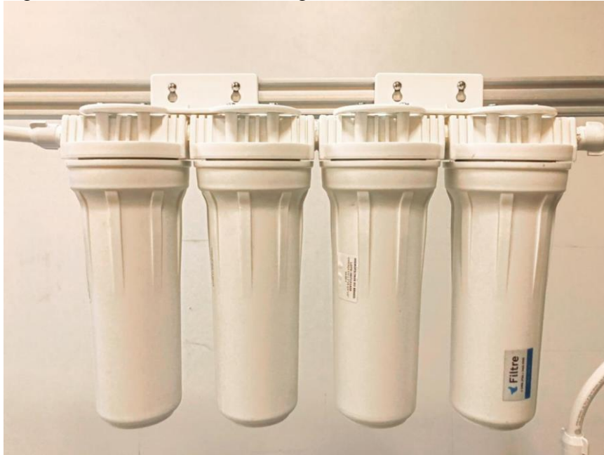
Figura 15 – Sistema de Pré-filtragem
