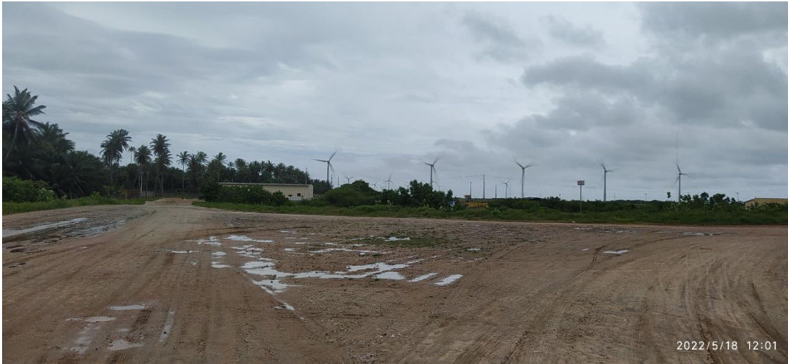
Figura 14 – Estrada de acesso aos aerogeradores em 2022
