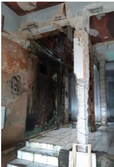
**Figura 4.9** - Pilar e vigas com ferragens aparentes.
