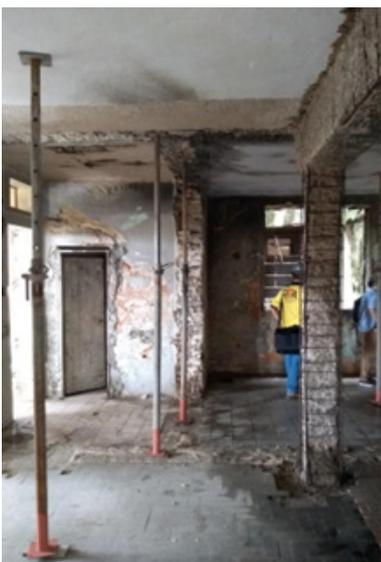
**Figura 4.10** - Escoramento para assegurar a sustentação do edifício.
