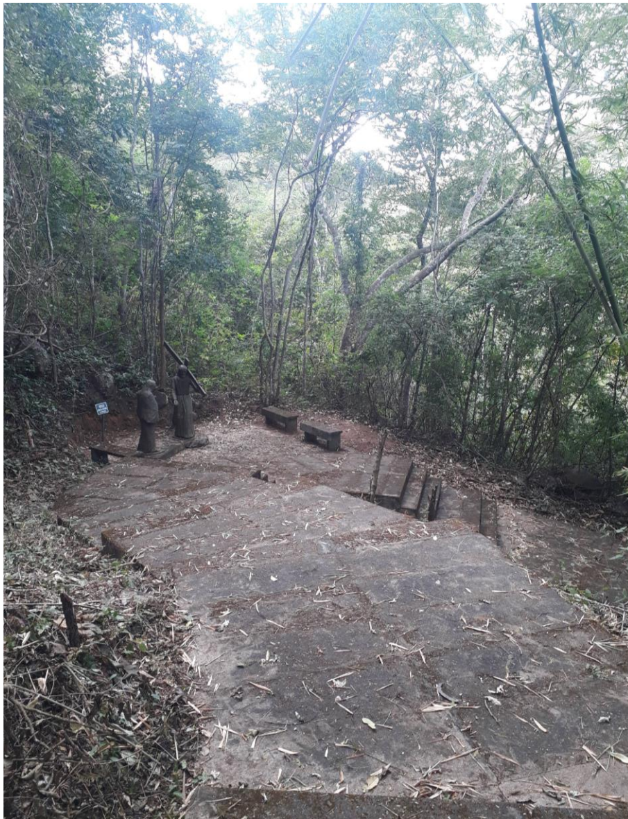
Figura 6. Trecho da escadaria.
