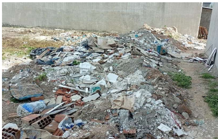
Figura 2: Disposição de RCD a céu aberto.
