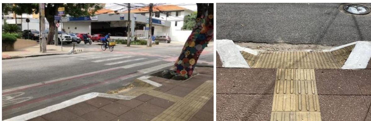
Figura 45 – Rampas de acesso à praça
