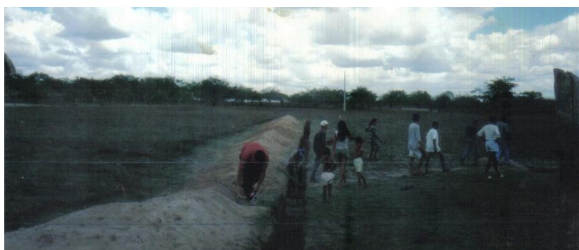
FIGURA 30: Construção da barragem subterrânea. (Fonte: Acervo da Comunidade).
