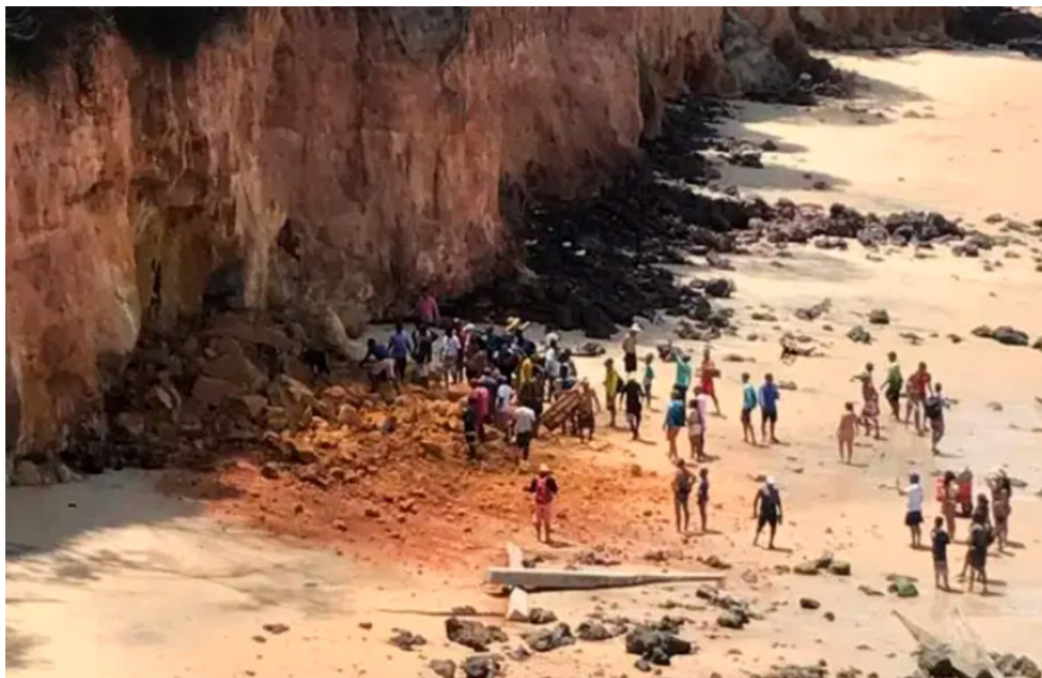
Figura 23 – Foto do colapso de blocos que vitimou a família em Pipa-RN (Fonte: globo.com)
