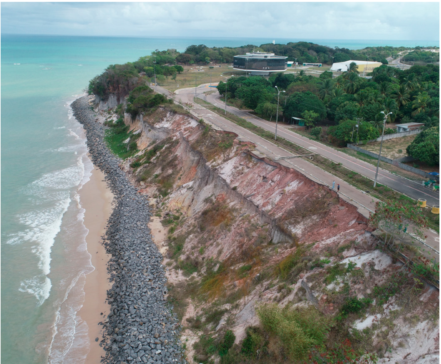
Figura 46 – Erosão da Falésia em João Pessoa – PB
