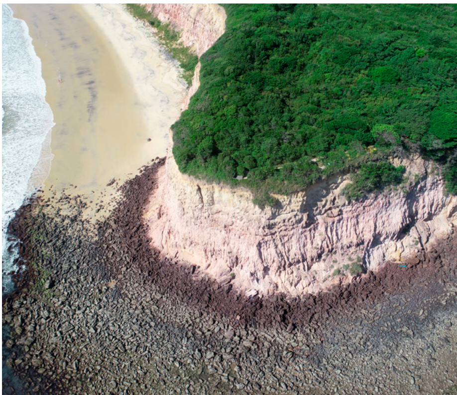
Figura 30 – Foto do promontório que divide a Baía dos Golfinhos e a praia do Madeiro. Densa ocorrência de blocos de laterita que protegem a base do promontório litorâneo
