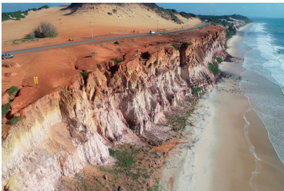
Figura 35 – Falésia ravinada na Praia de Cacimbinhas (Visão de sul para norte)
