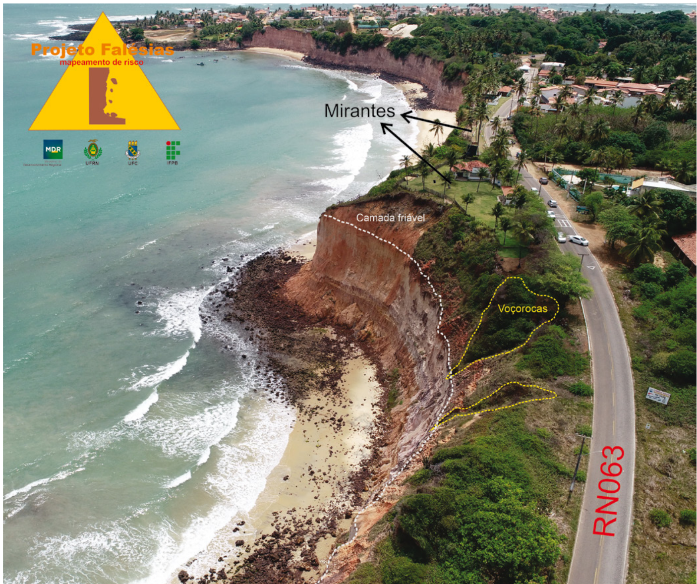
Figura 43 – Voçorocas à margem da RN063
