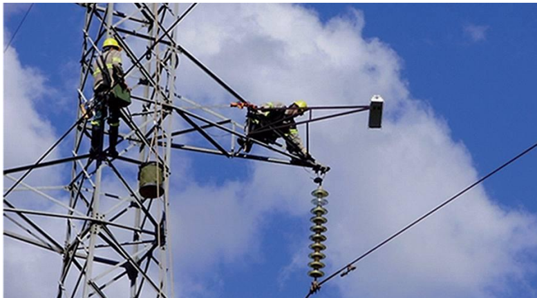
Figura 27 – Instalação dos sensores de medição climatológicos.
