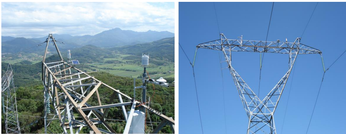
Figura 28 - Instalação de Estações Compactas no topo da torre de transmissão.
