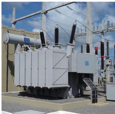
**Figura 7.1** Transformador utilizado em subestação transformadora.
