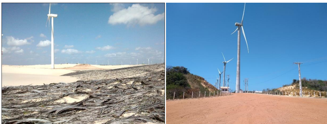
Figura 27: Palhas utilizadas para conter a erosão e vias de acesso aos aerogeradores.
