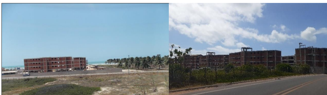
Figura 24: Hotéis em construção na planície litorânea.
