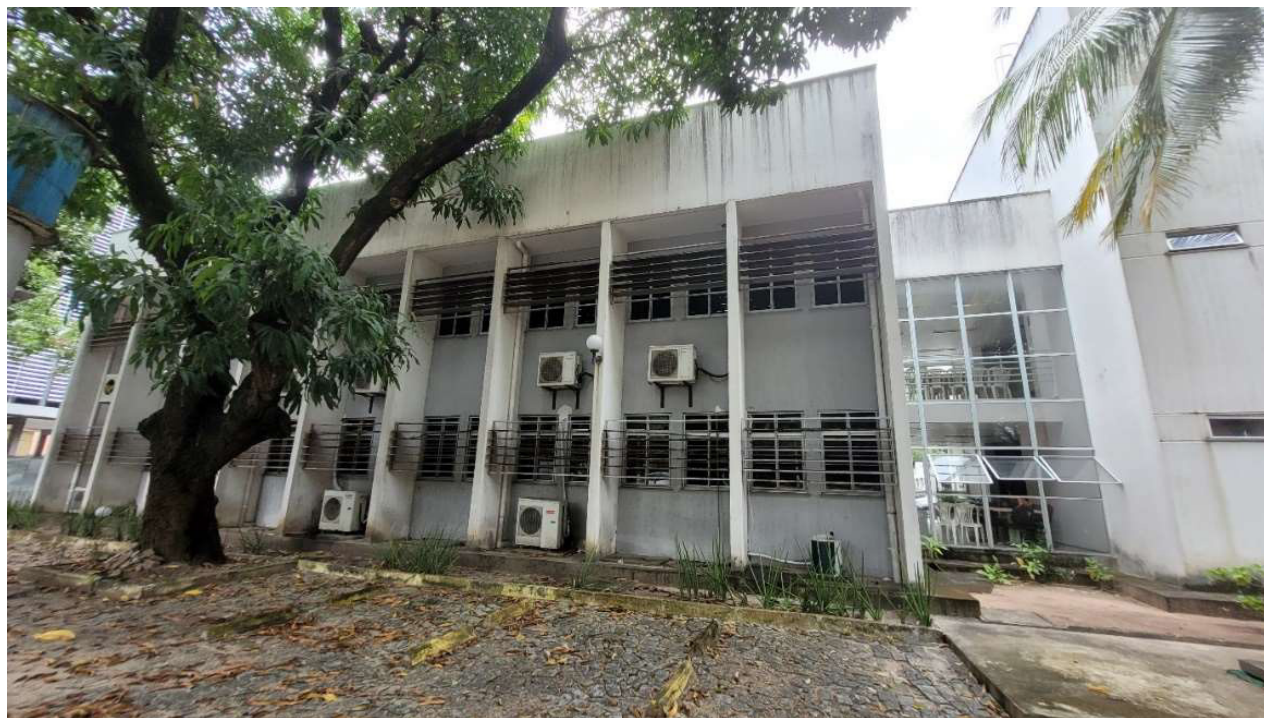
Figura 8 - Fachada posterior da edificação(sudoeste).
