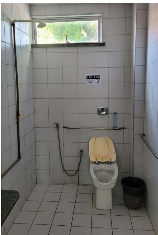
Figura 30 - Banheiro para portadores de necessidades especiais, pavimento térreo.
