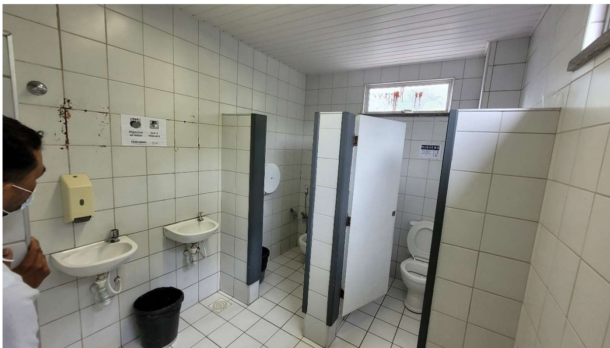
Figura 29 - Banheiro Masculino, pavimento superior.
