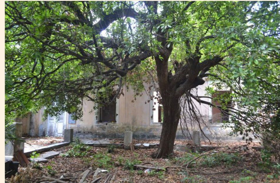
Imagem 7 – Registro do pátio externo da casa, da fachada oeste
