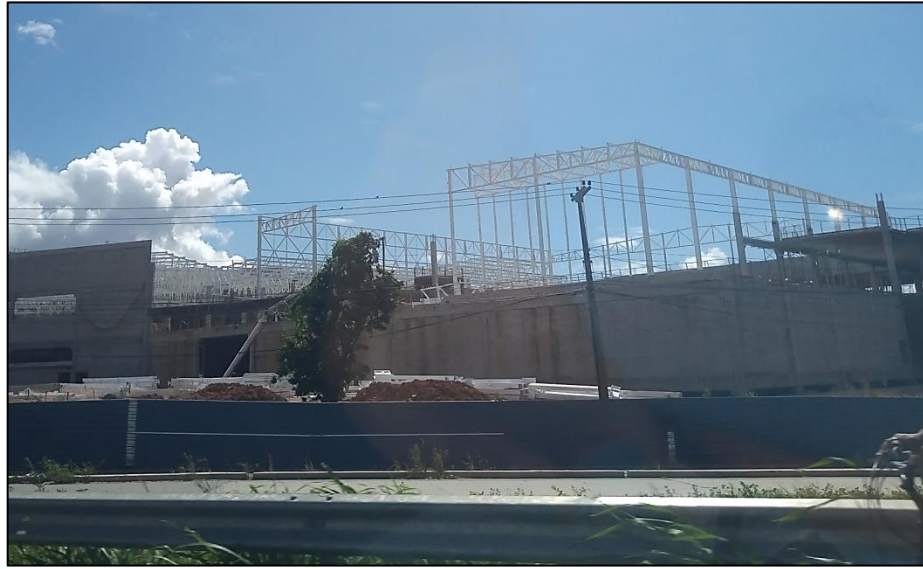
Figura 26 - Construção de shopping na Rodovia CE-040
