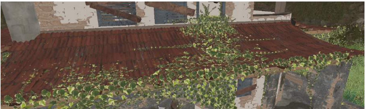
Figura 53 - Trepadeiras aplicadas no telhado.
