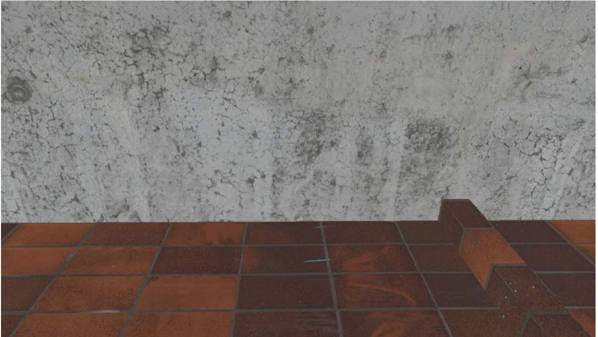
Figura 26 - Materiais do banheiro
