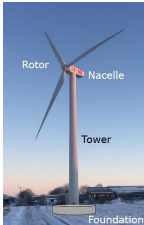
Figura 19 - Componentes básicos de uma turbina.
