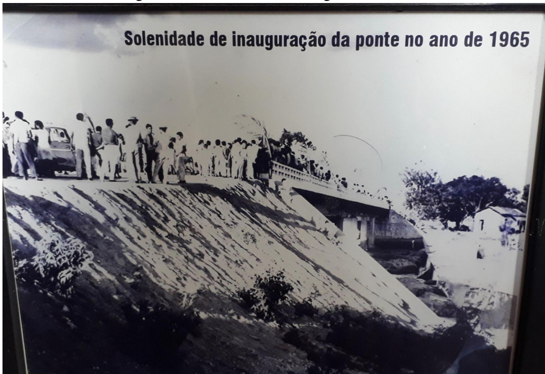
Figura 2 – Ponte sobre o rio Salgado em Aurora
