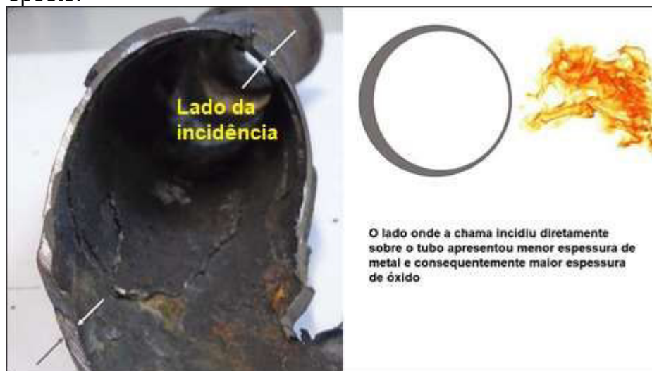
Figura 23 – Seta mostrando menor espessura da parede do tubo no lado da incidência de chamas, em comparação com o lado oposto.
