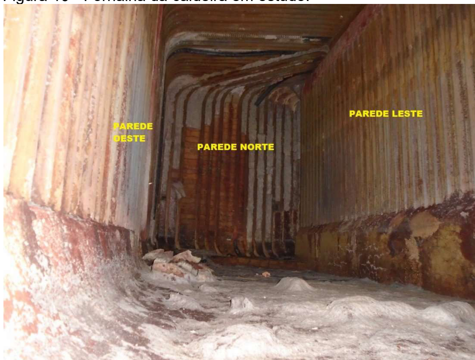
Figura 10 - Fornalha da caldeira em estudo.
