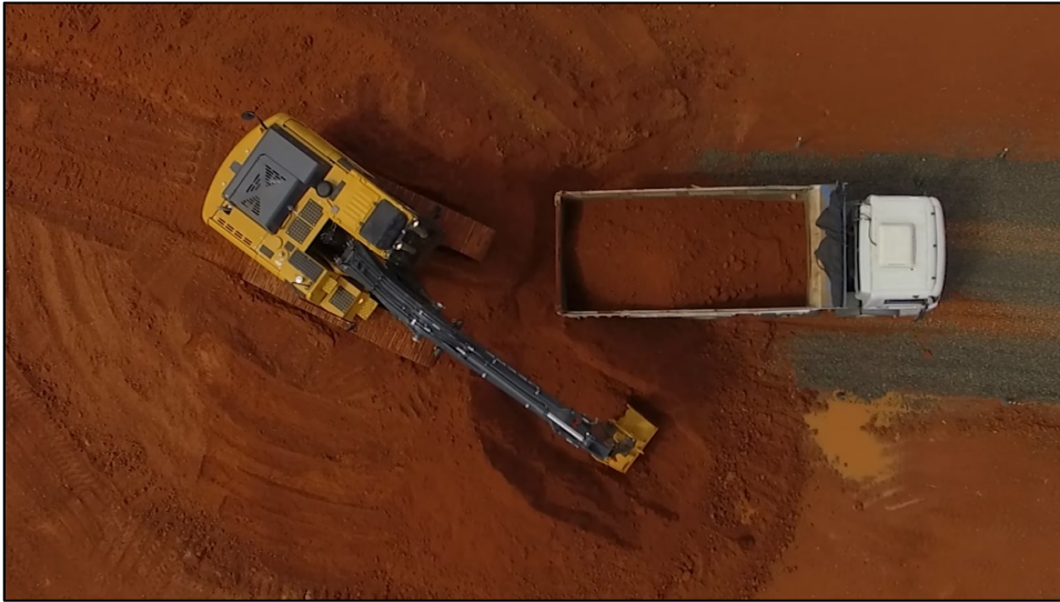
Figura 35 – Escavação a 45^\circ do ponto de despejo.
