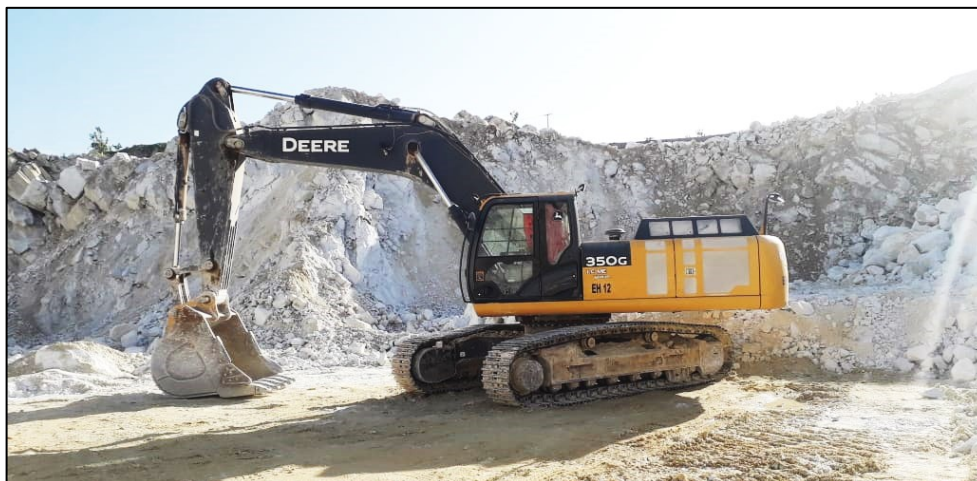
Figura 22 – Escavadeira hidráulica John Deere 350G.
