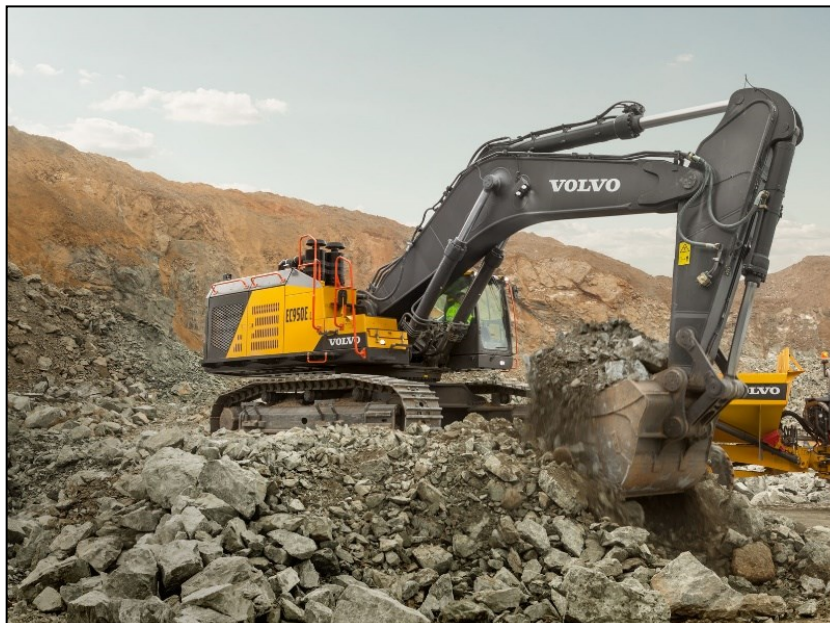
Figura 8 – Retroscavadeira hidráulica (Volvo EC950E).
