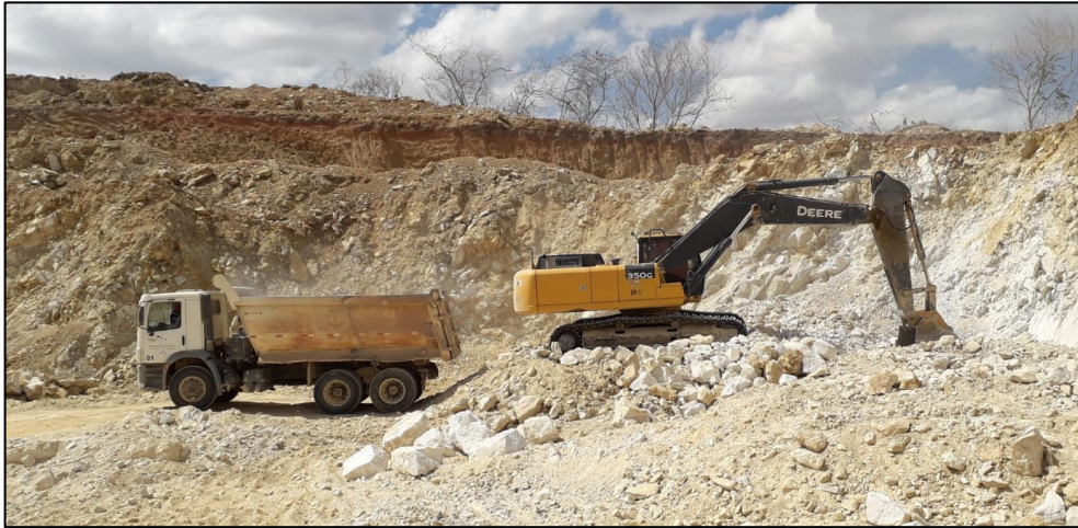
Figura 33 – Escavação a 180° do ponto de despejo.
