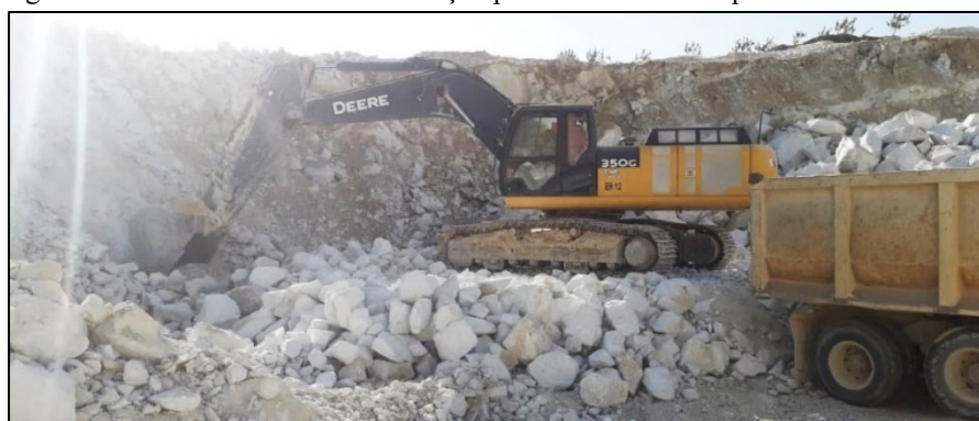
Figura 31 – EH 01 executando escavação posicionada sobre a pilha de material.
