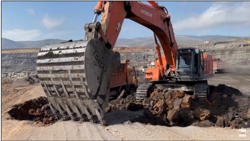
Figura 2 – Desmonte mecânico com escavadeira.
