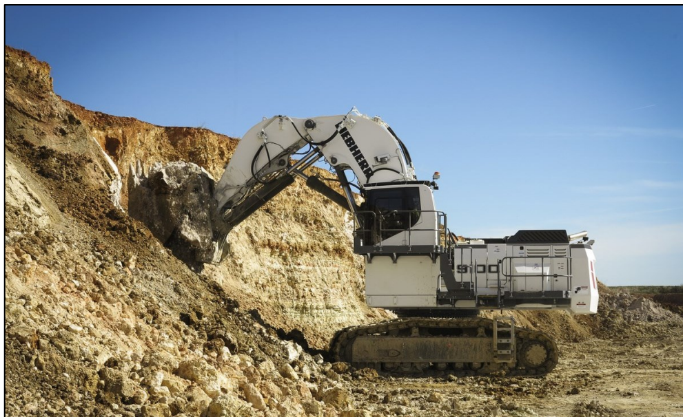
Figura 7 – Shovel hidráulica (Liebherr R 9100B).
