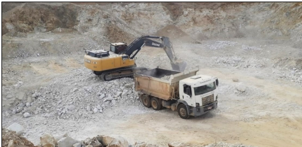
Figura 34 – Escavação a 90° do ponto de despejo.
