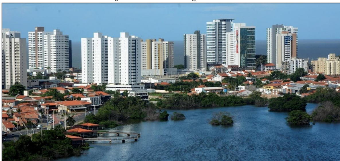
Figura 27 – Edifícios na Laguna da Jansen
