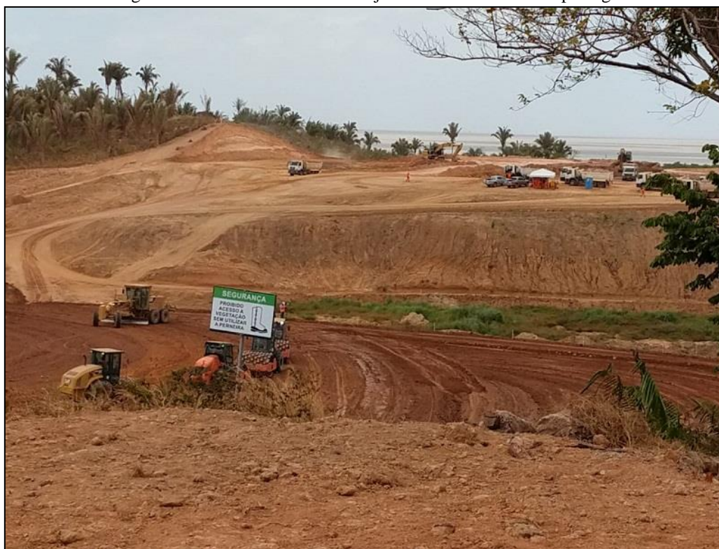
Figura 53 – Área desmatada no Cajueiro com obras de terraplanagem
