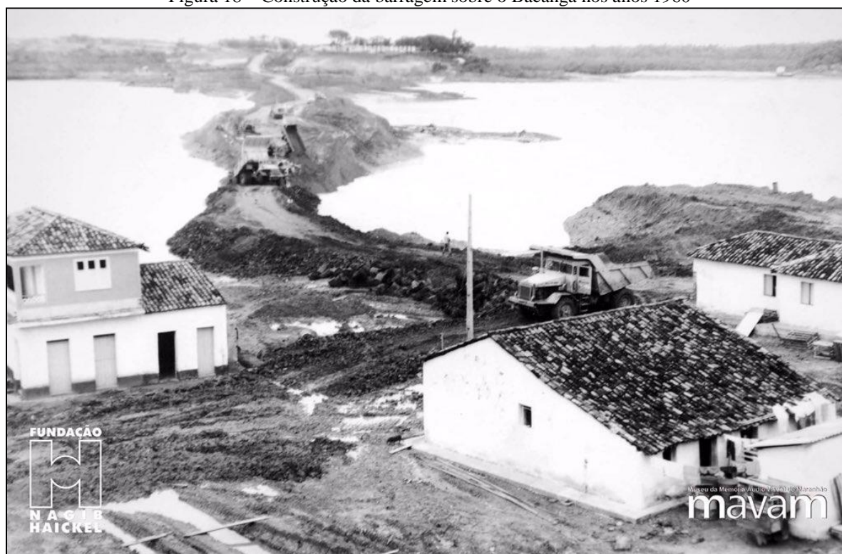
Figura 18 – Construção da barragem sobre o Bacanga nos anos 1960
