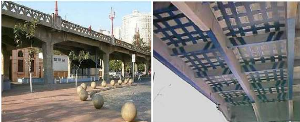
Figura 2 – Viaduto de Santa Teresa em Belo Horizonte - MG
