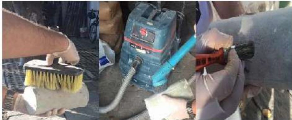
Figura 7 – Limpeza do concreto
