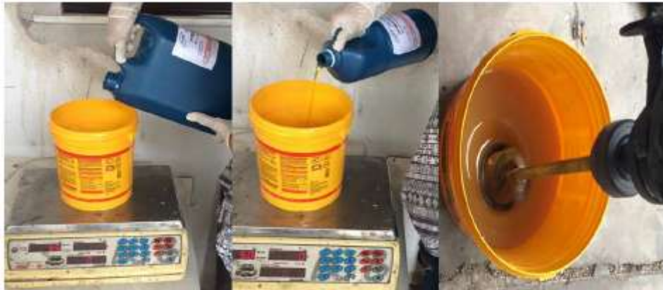
Figura 12 – Preparação da resina epóxi saturante
