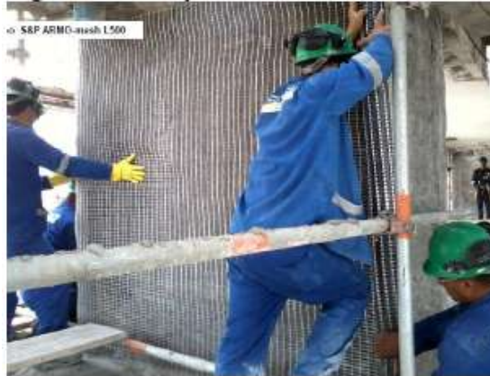
Figura 3 – Reforço de pilares de concreto no estádio Maracanã
