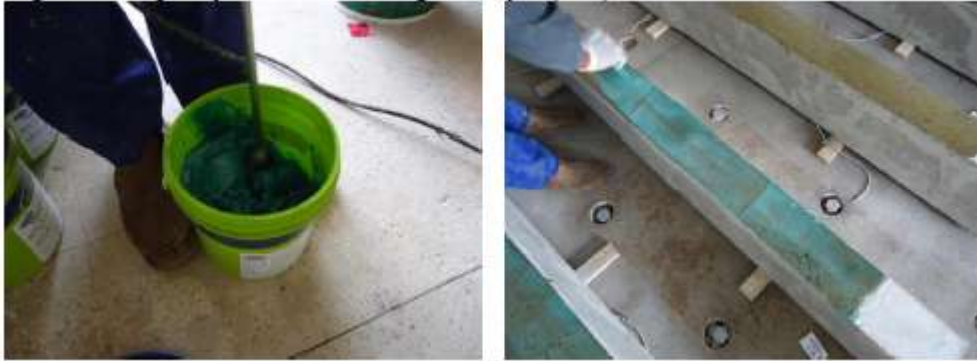
Figura 11 – Preparação e aplicação da resina de regularização
