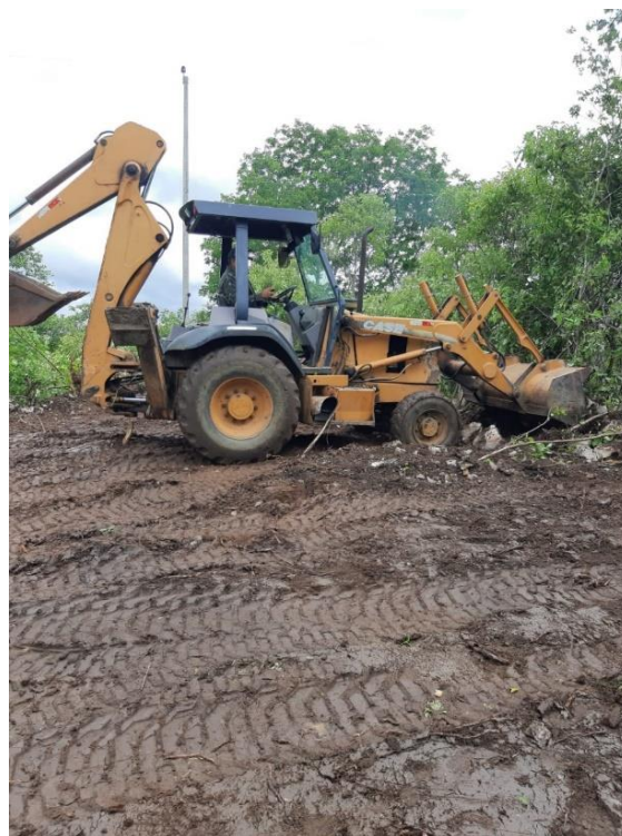
Figura 11- Limpeza da área do pegmatito com retroscavadeira modelo CASE 580L.
