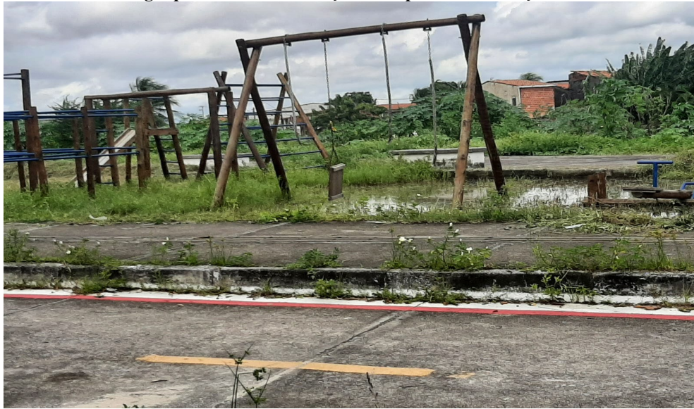
Figura 13: Equipamento instalado (parquinho infantil) através de Projeto Sócio Ambiental Rio Maranguapinho sem manutenção e em péssimas condições de uso
