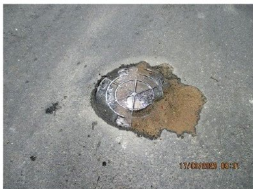
7. Poço de Visita sem extravasamento
