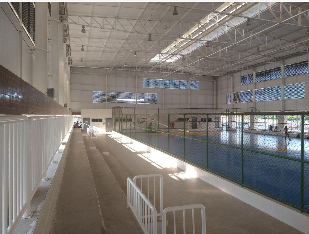
Figuras 36 e 37. Fotos da quadra de areia e do ginásio coberto do Cuca José Walter. Fonte: Fotos do acervo do autor (de agosto de 2021)
