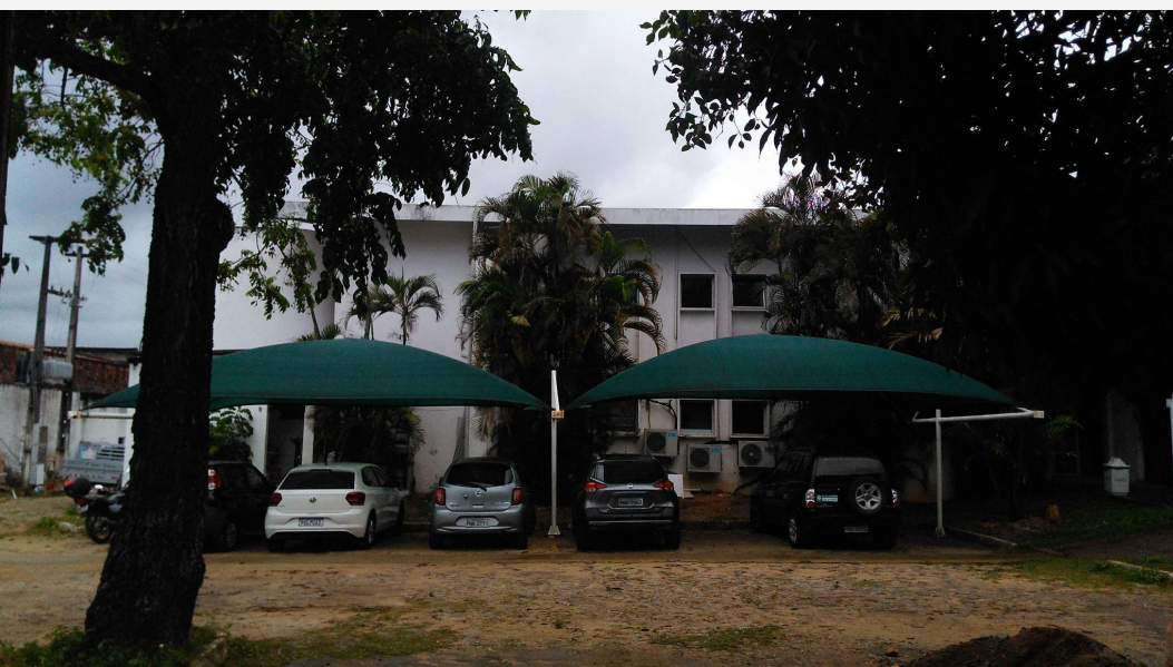
Figuras 43, 44 e 45. Fotografias da Sede da Cagece, enfatizando elementos arquitetônicos (entrada com o Bloco A ao fundo, bloco do refeitório e bloco D). Fonte: Fotos do acervo do autor (de janeiro de 2020)
