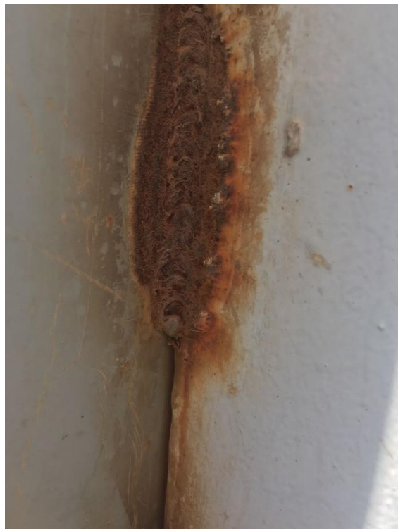
Figura 13 - Visualização da fresta entre painel e coluna
