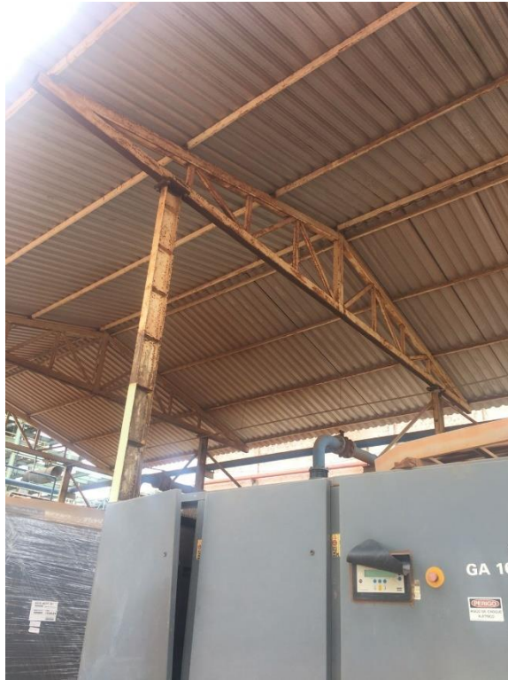
Figura 15 - Cobertura da casa de compressores
