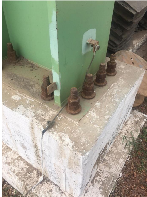
Figura 17 - Sapata de coluna metálica
