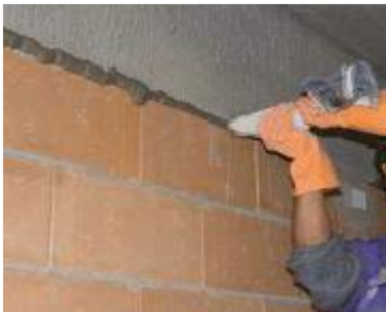
Figura 2.9- Encunhamento com expansor.
