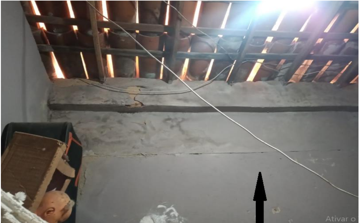
Figura 4.29 - Trinca horizontal
