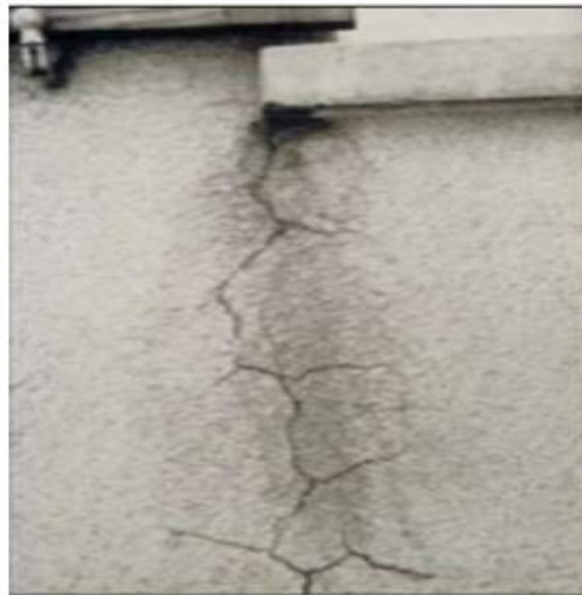
Figura 2.12 - Fadiga por expansão e retração higroscópica
