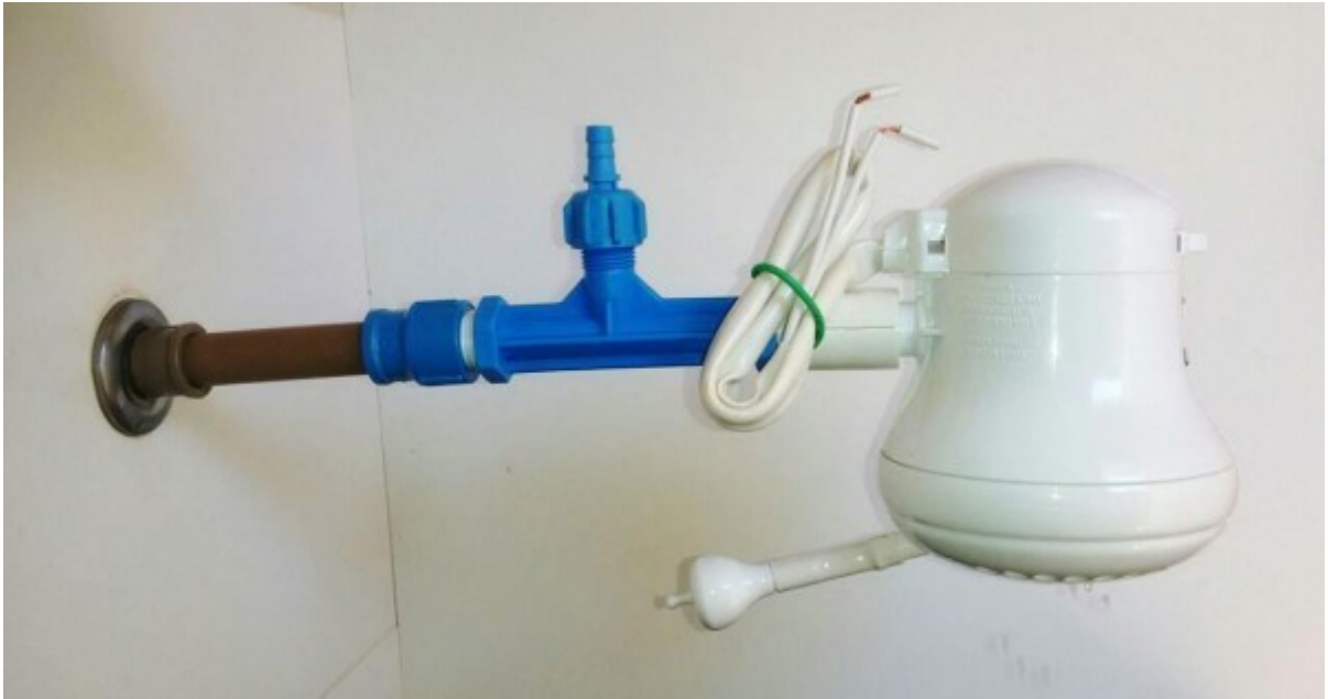
Figura 7 – Tubo de Venturi instalado em um chuveiro.
