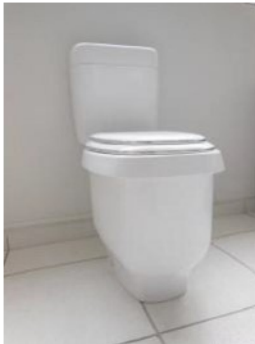
Figura 9 – Exemplo de uma bacia sanitária com consumo de 2 litros por descarga
