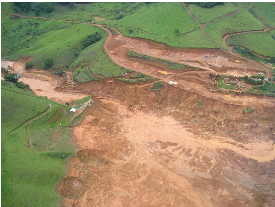
FIGURA 5.8 – Acidente com a Barragem São Francisco da Mineração Pomba-Cataguases (Miraf - MG) – janeiro/2007
