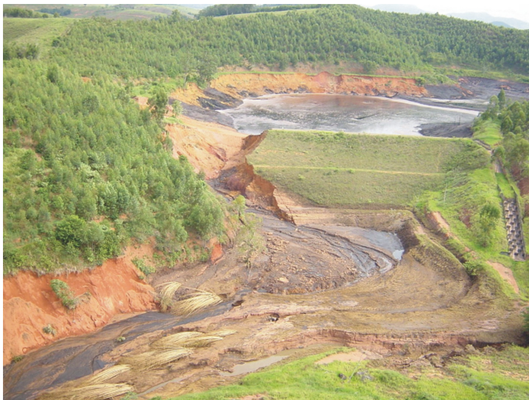
FIGURA 5.2 – Acidente com a Barragem B da Florestal Cataguases (Cataguases-MG) – março/2003
