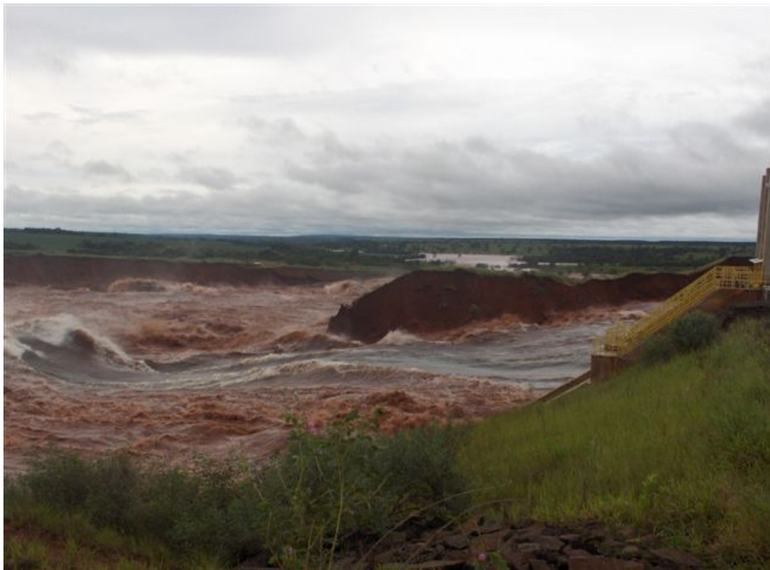
FIGURA 5.11– Acidente com a Barragem Espora (GO) – janeiro/2008
