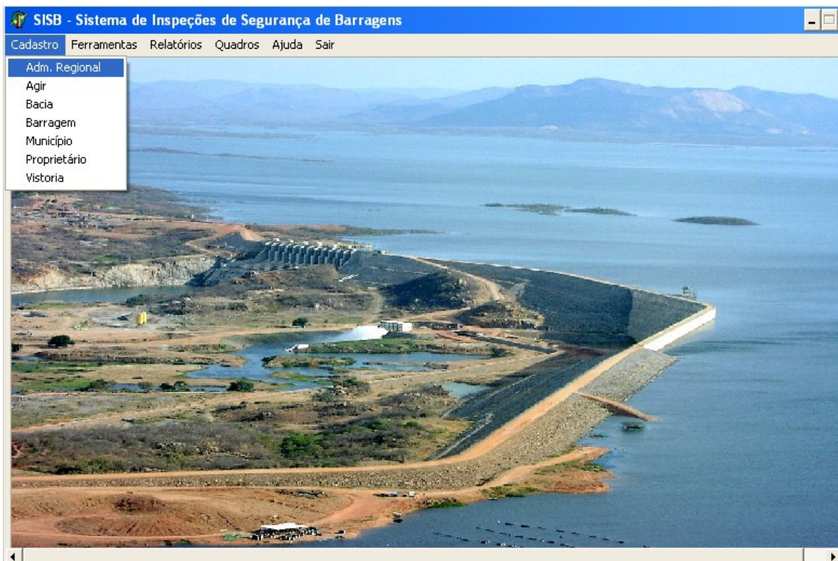
FIGURA 5.20 – Sistema de Inspeção e Segurança de Barragens – SISB.
