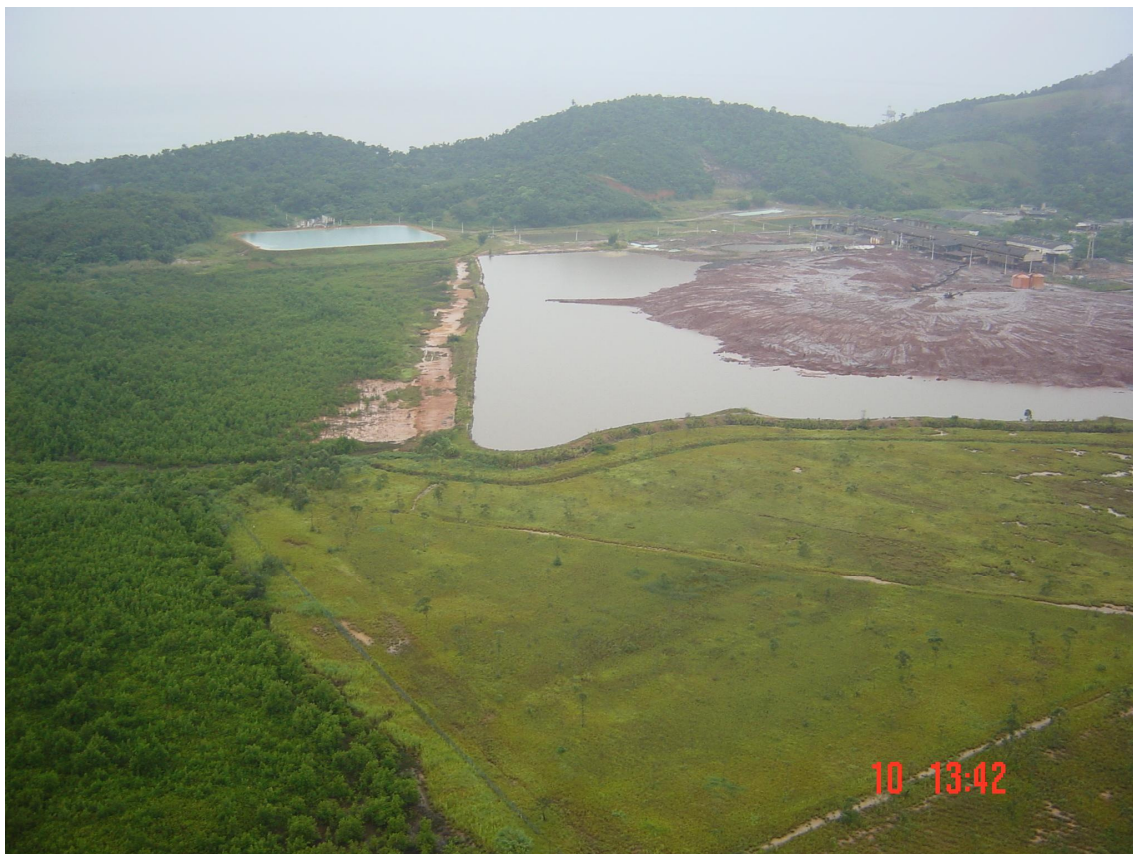
FIGURA 5.4 – Acidente com a Barragem da Indústria Ingá (RJ) – abril/2003
