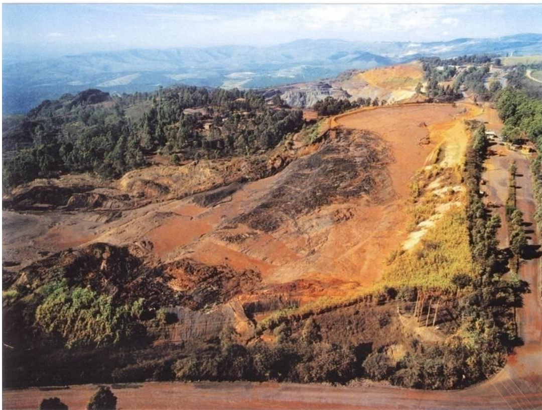
FIGURA 5.1 – Acidente com a Barragem da Mineração Rio Verde (Nova Lima-MG) – junho/2001
