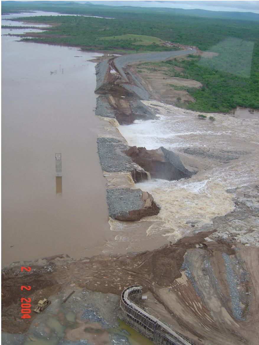
FIGURA 5.3 – Acidente com a Barragem Arneiroz II (CE) – jan 2004.
