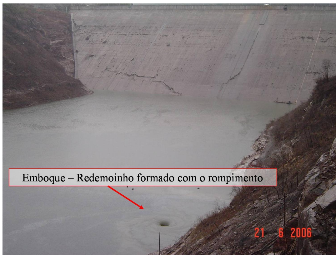
FIGURA 5.9 – Acidente com a Barragem Campos Novos (SC) – junho/2006
