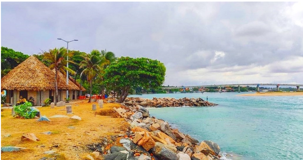
Figura 7 – Estágio atual das obras
