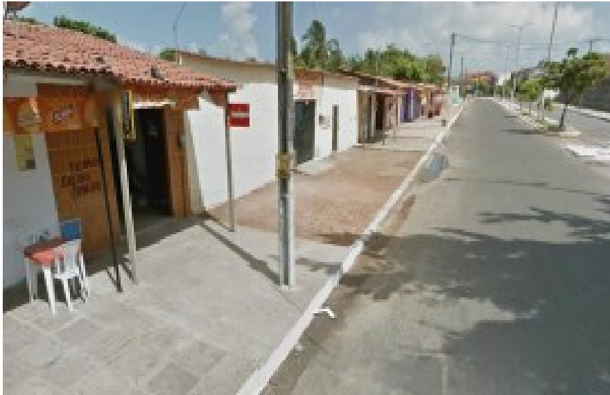
Figura 4 – Região da Av. da Praia, em 2012, antes da demolição das casas
