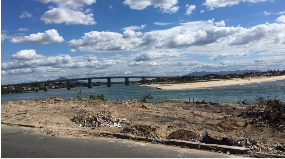
Figura 6 – Demolição das casas para expansão do projeto de requalificação urbana
