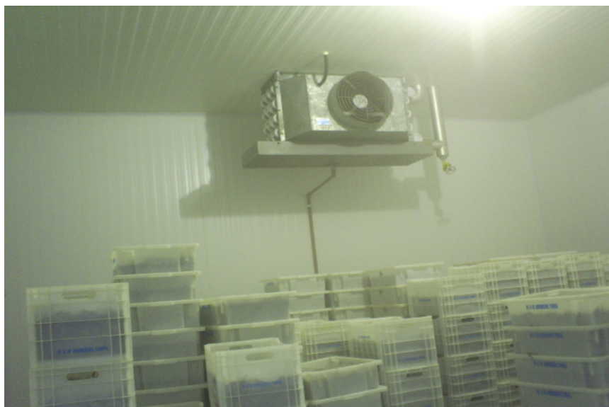
Figura 12 – Câmara de espera na CINA, em Fortaleza – Ceará
