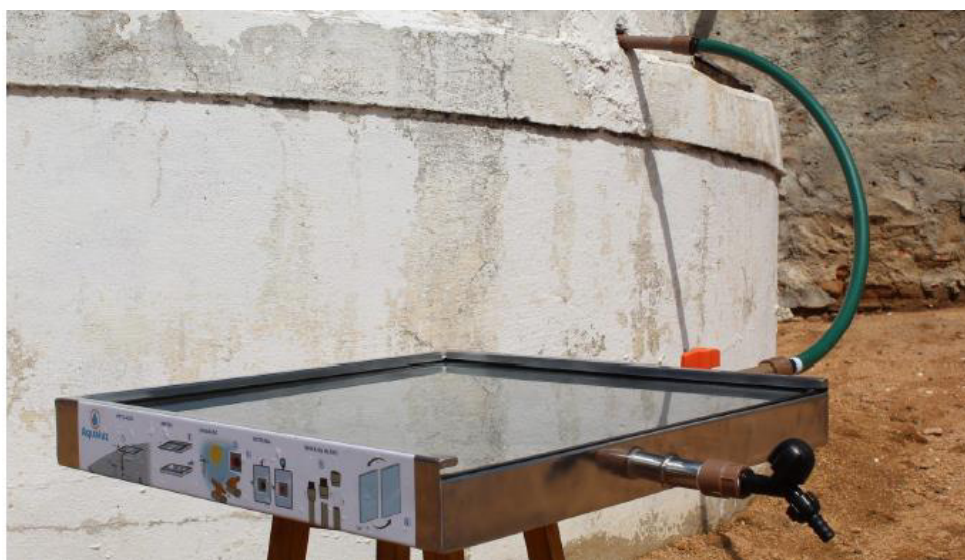
Figura 2 – Aqualuz instalado em cisterna
