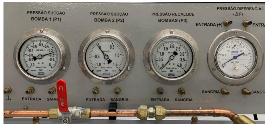
Figura 15 – Válvula de acesso da tubulação da perda de carga
