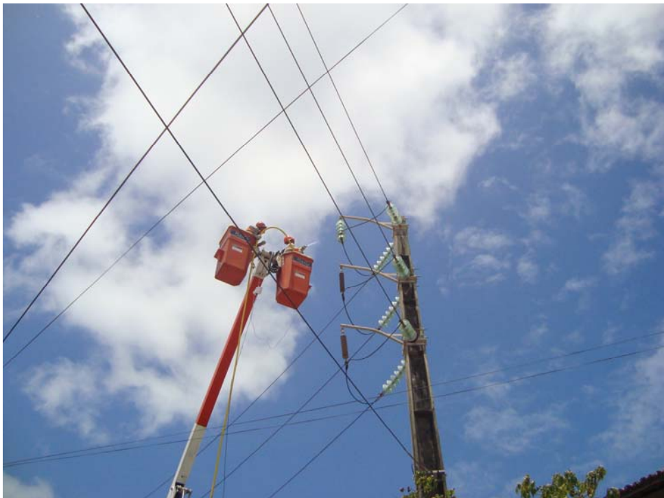
Figura 4.25 - Limpeza de isoladores de uma linha de 69 kV no Mucuripe (foto do autor).
