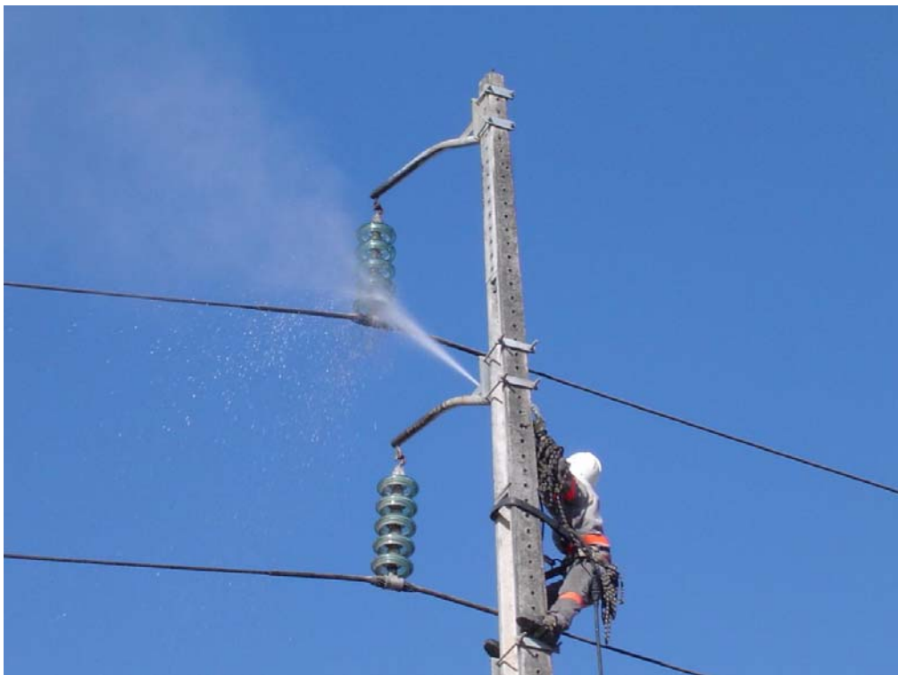
Figura 1.4 - Maior detalhe da lavagem convencional de forma manual.
