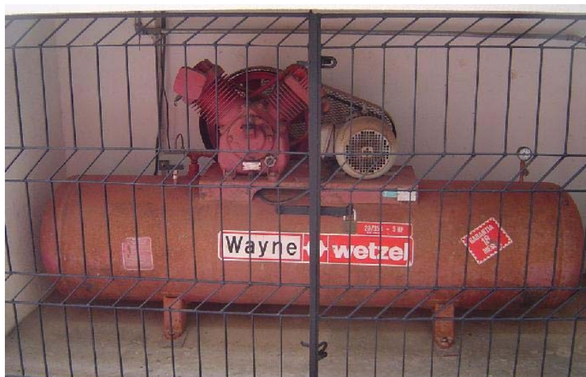
Figura 3.15 - Compressor a pistão com pressão máxima de trabalho de 12,1 bars e vazão de 577 litros por minuto (foto do autor).
