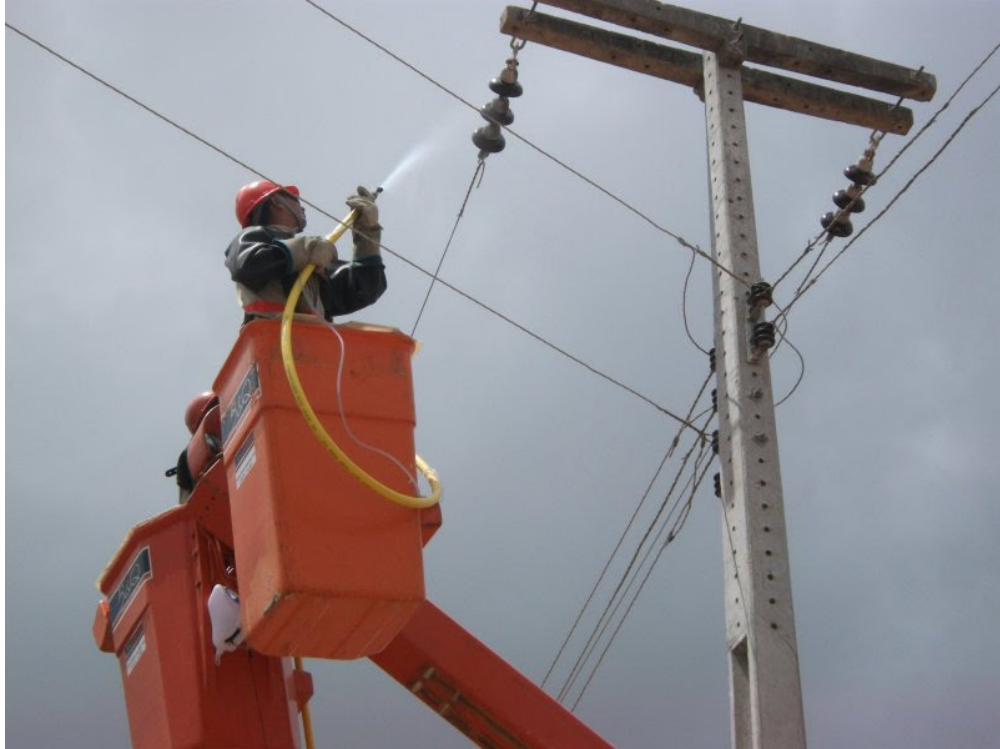
Figura 4.28 - Limpeza das cadeias de isoladores tipo disco de porcelana em uma linha de distribuição de 13,8 kV na praia da Sabiaguaba (foto do autor).
