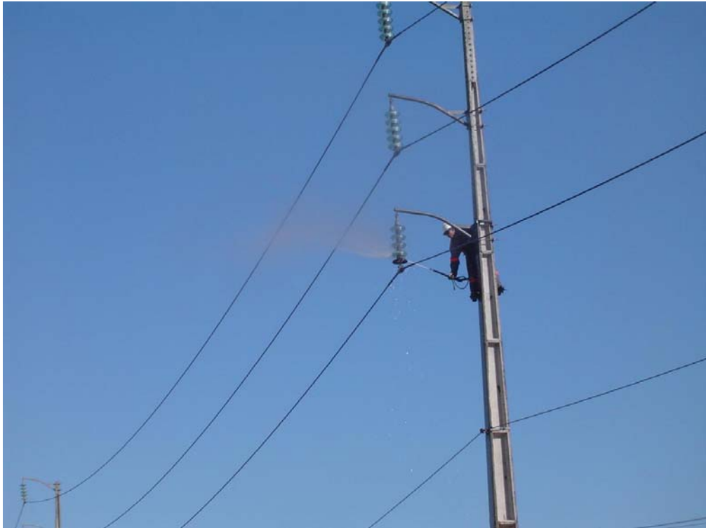
Figura 1.5 - Outro ângulo da lavagem convencional de forma manual.
