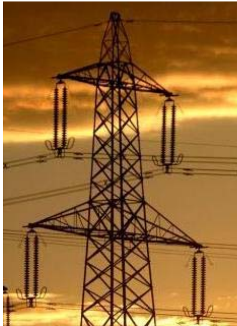
Figura A.26 - Cadeia de isoladores em suspensão simples [23].
