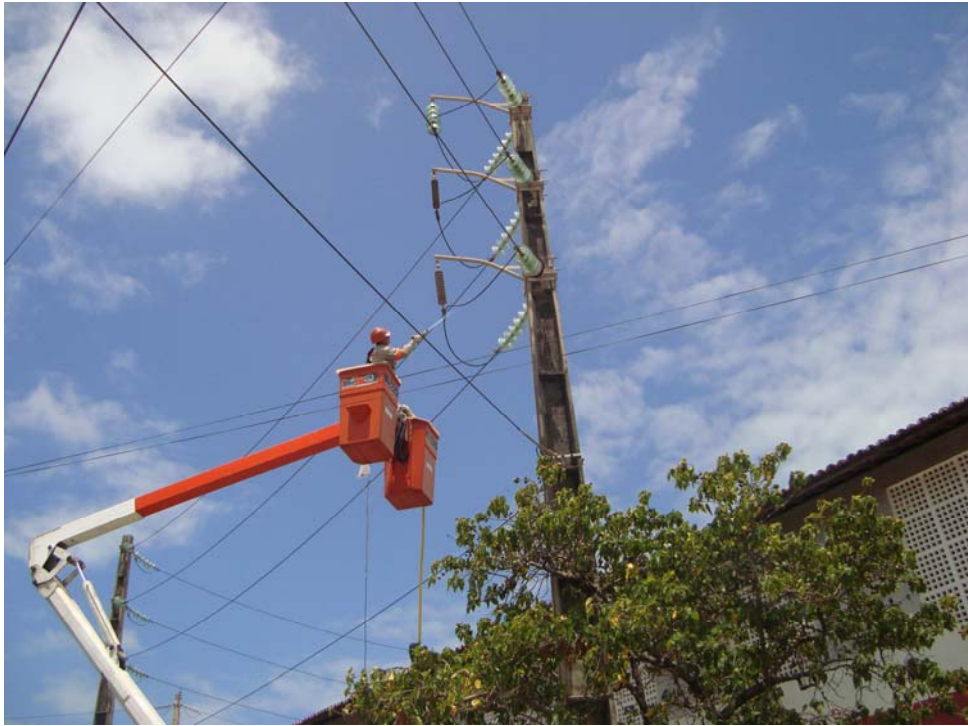
Figura 4.24 - Limpeza de isoladores de uma linha de 69 kV no Mucuripe (foto do autor).
