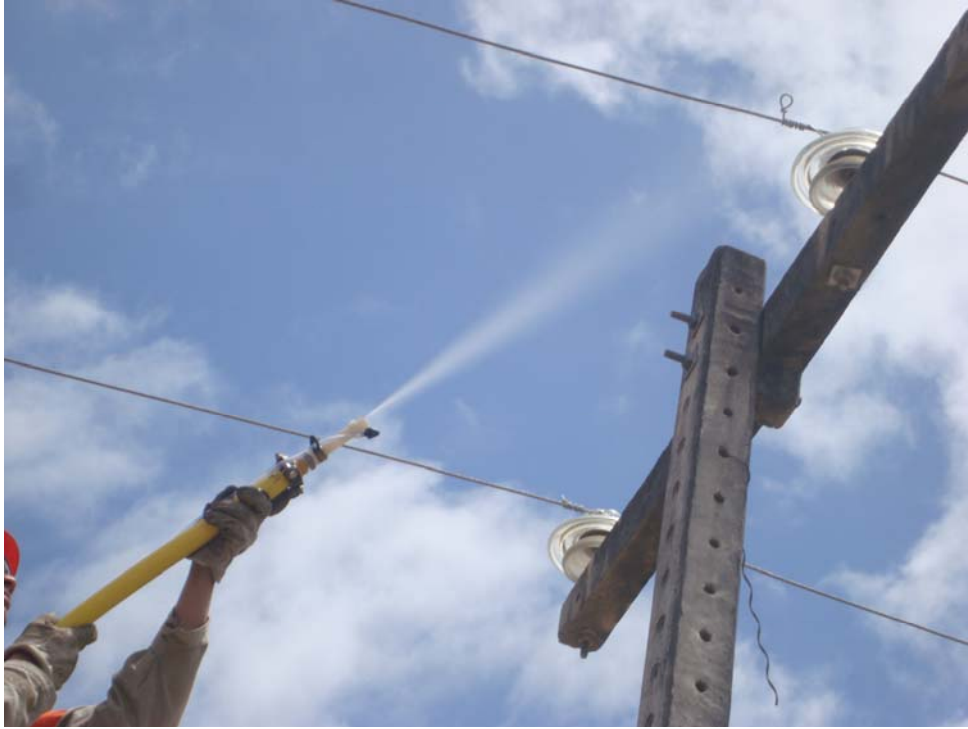
Figura 4.18 - Limpeza dos isoladores tipo pino multicorpo de vidro (foto do autor).
