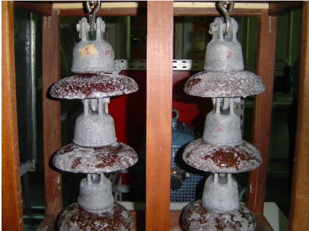
Figura 3.5 - Estrutura de sustentação e transporte das cadeias de isoladores (foto do autor).
