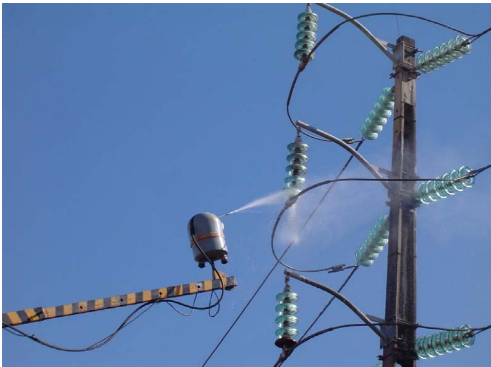
Figura 1.3 - Maior detalhe da lavagem convencional com robô.
