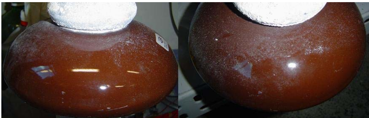
Figura 3.53 - Cadeia de isoladores tirada da rede de distribuição (foto do autor).
