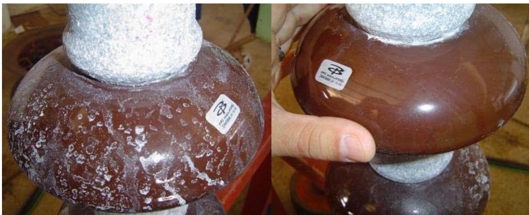
Figura 3.43 - Isoladores antes e depois da limpeza com ar comprimido (foto do autor).
