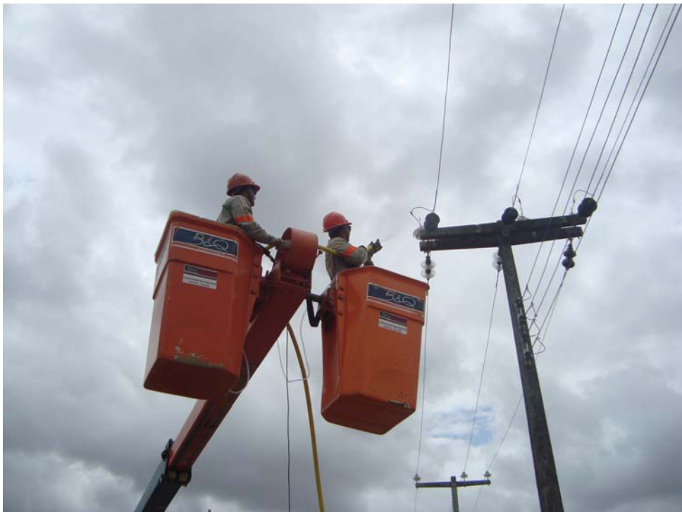
Figura 4.17 - Limpeza das cadeias de isoladores tipo disco de porcelana (foto do autor).
