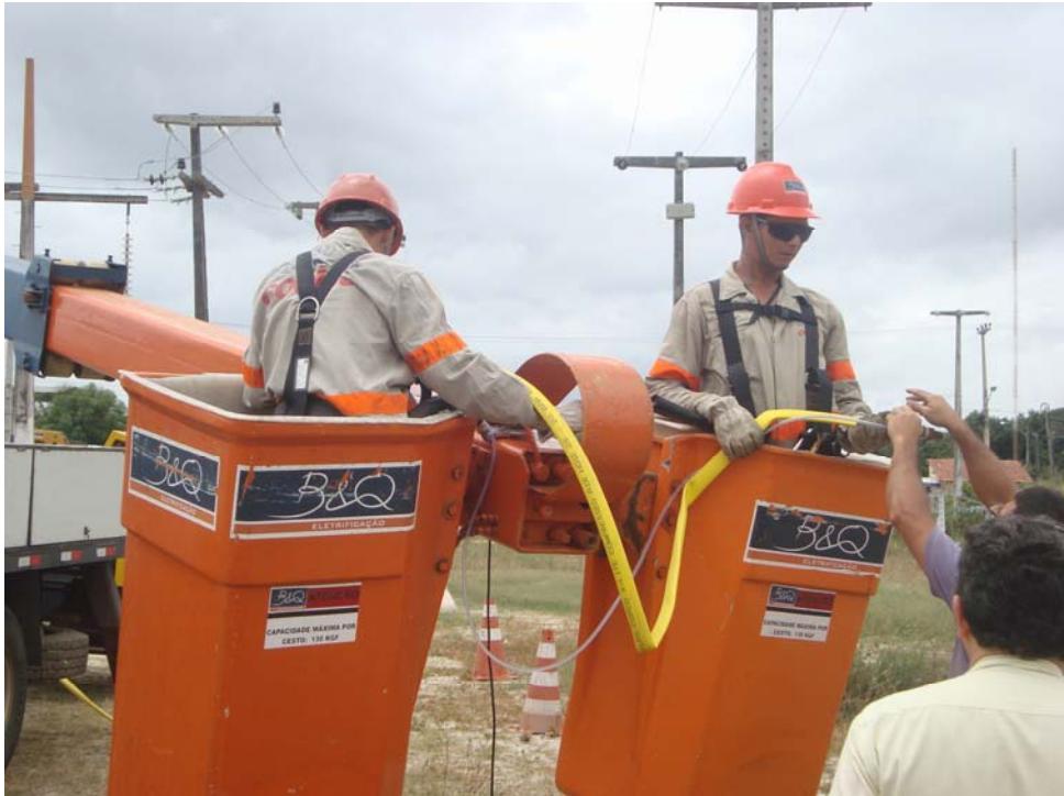
Figura 4.13 - Posicionamento dos eletricitistas no cesto (foto do autor).
