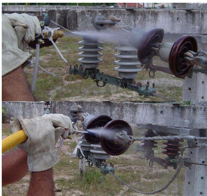
Figura 4.8 - Aplicação do procedimento alternativo no centro de treinamento (postes de altura reduzida) (foto do autor).
