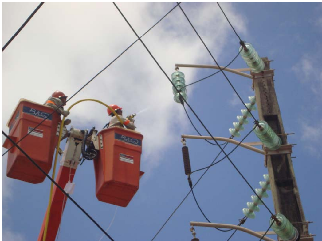
Figura 4.26 - Limpeza de isoladores de uma linha de 69 kV no Mucuripe (foto do autor).
