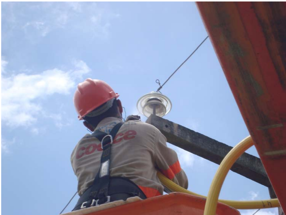
Figura 4.19 - Limpeza dos isoladores tipo pino multicorpo de vidro (foto do autor).
