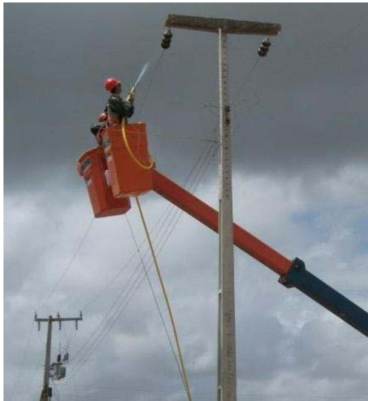
Figura 4.29 - Limpeza das cadeias de isoladores tipo disco de porcelana em uma linha de distribuição de 13,8 kV na praia da Sabiaguaba (foto do autor).
